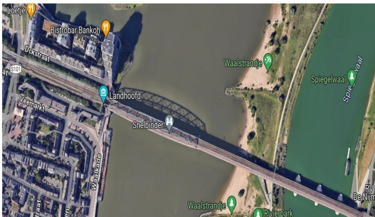
Verbetering ontsluiting Nijmegen Noord/Zuid tijdens Waal in Vlammen
