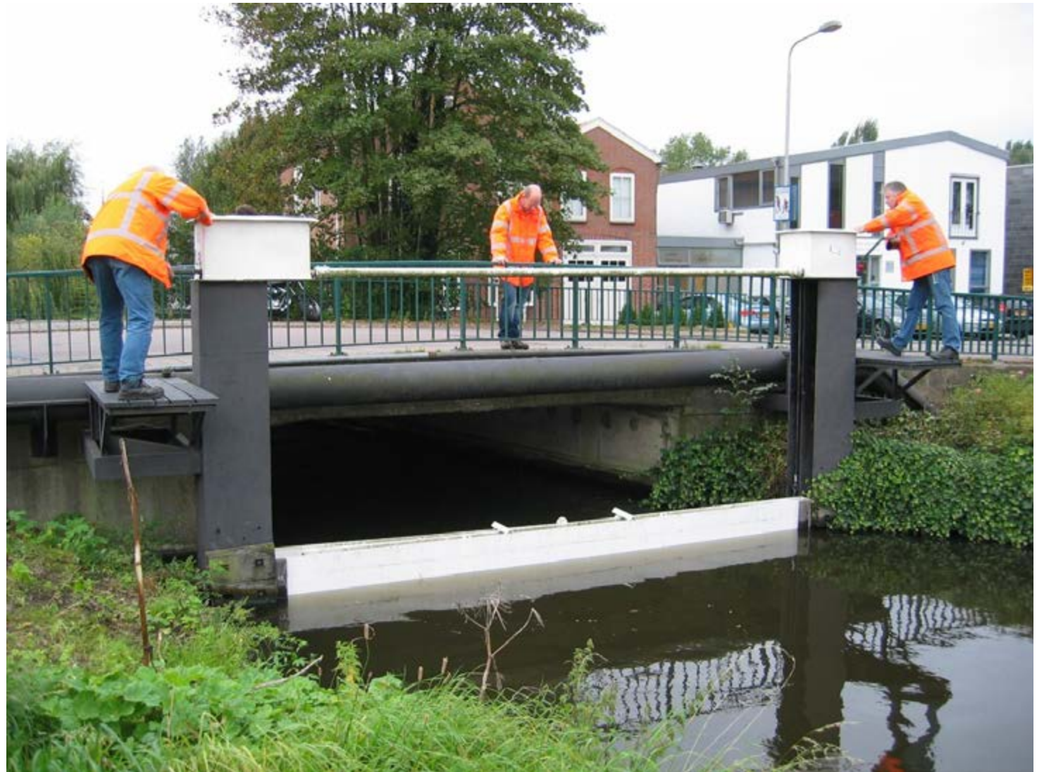
Figuur 2-2-3: Calamiteiten oefening sluiten van compartimenteringswerk op de Stommeerweg in Aalsmeer
