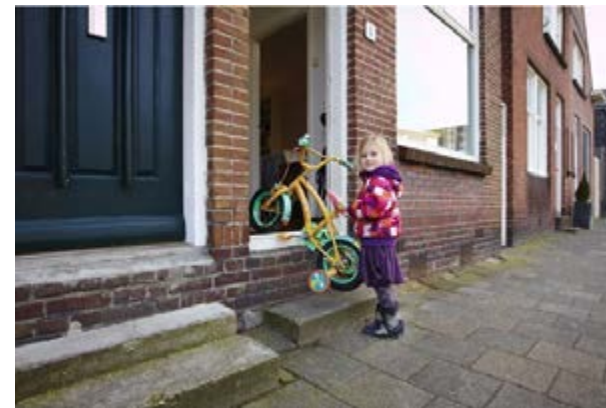
Figuur 3-4: Verzakking bij Gouda door bodemdaling
