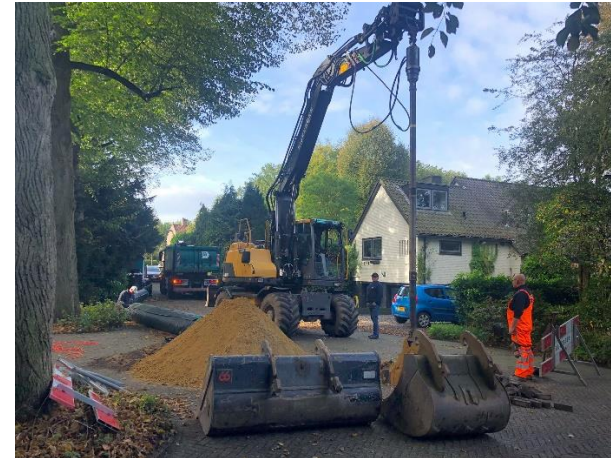
Figuur 2-2 Boring van verticale infiltratieputten
