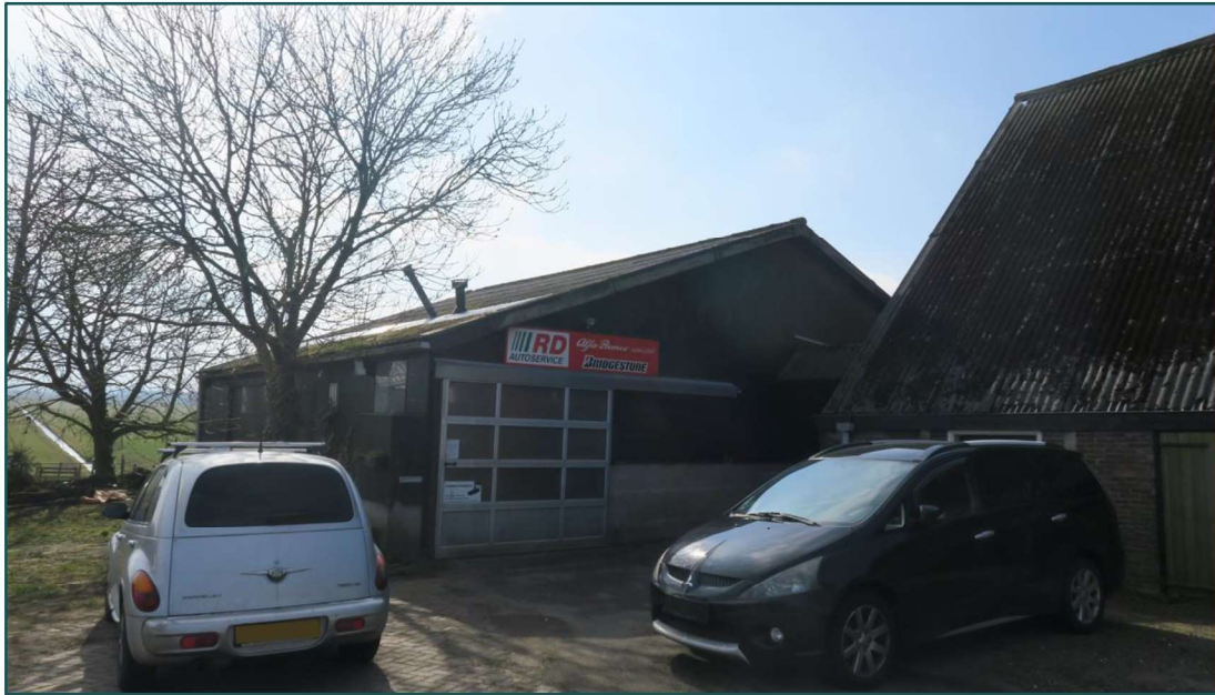
Figuur 1.3 De autogarage en naastgelegen schuur worden gesloopt in de beoogde ontwikkeling.
