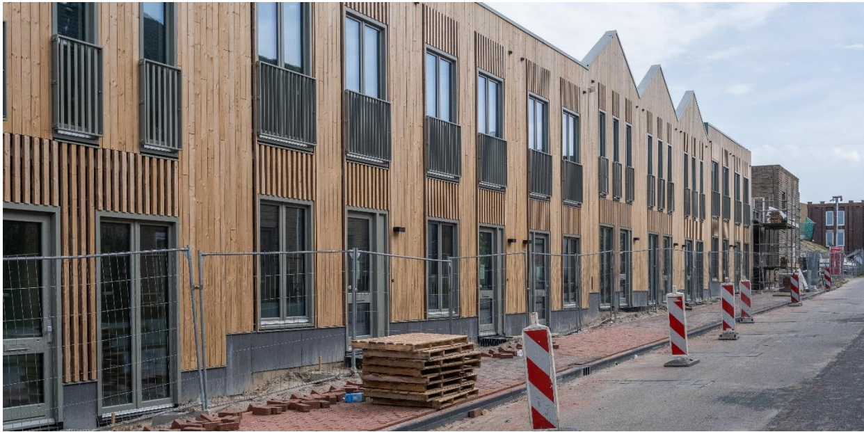
Figuur 11: circulair biobased bouwen in het project de Omloop te Leeuwestejn. GeWOONhout in samenwerking met AM. Foto gemaakt door Johan Boterenbrood
