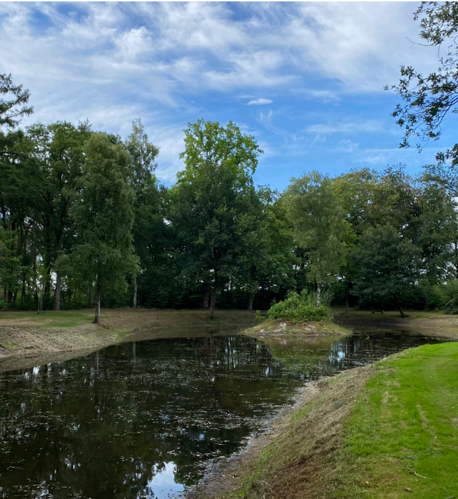
Herstel bol liggende oevers langs de vijver
