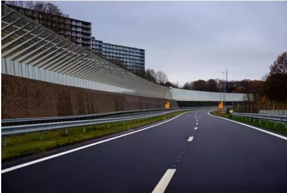
Figuur 3.1: Aanleg Buitenring Parkstad Limburg
