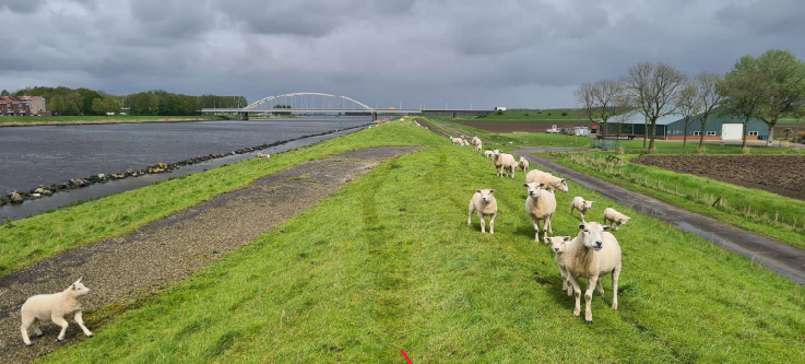
Inspectie pad aansluiten op bestaande asfaltbekleding
