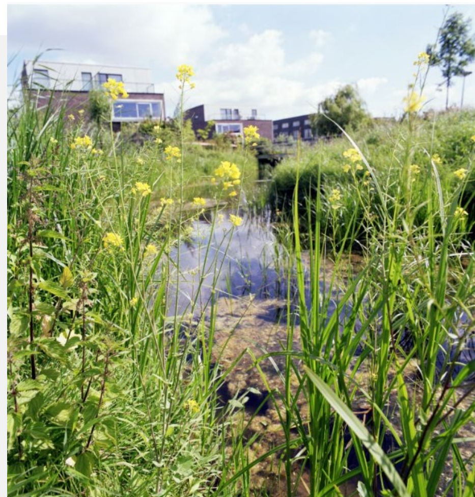
Figuur 4 Natuurlijke vijvers, sloten en wadi's fungeren als tijdelijke opslagplaats voor hemelwater. Bron: GAW | Stichting RIONED
