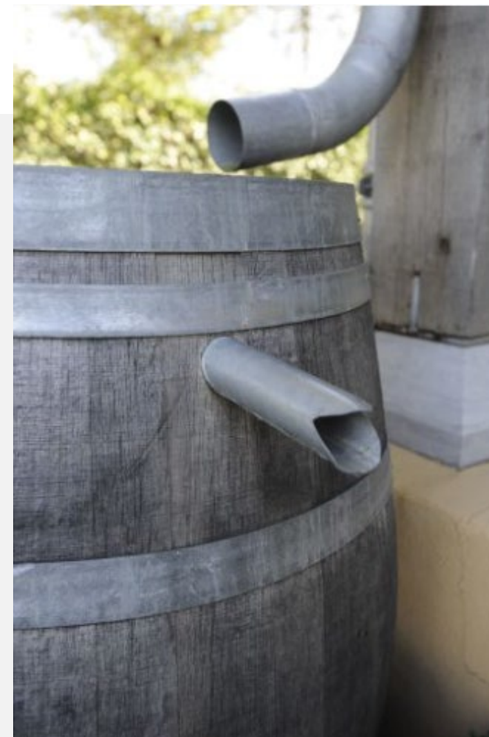
Figuur 8 Een regenton in de tuin is een voorbeeld van hergebruik van regenwater, om zuiniger om te gaan met water en minder drinkwater te verspillen. Bron: GAW | Stichting RIONED
