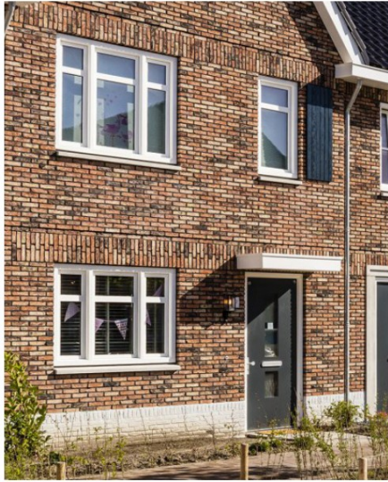
voorbeeld van plasticiteit in de gevel, rollaag, smetrand en luifel
