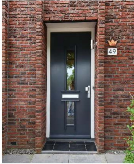
voorbeeld van plasticiteit in de gevel, rollaag, smetrand en luifel
