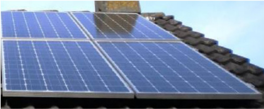
zonnepanelen in rechthoekig vlak leggen
