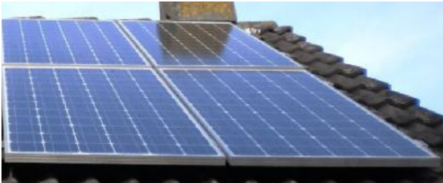
zonnepanelen in rechthoekig vlak leggen
