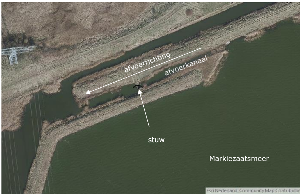
Figuur 3c: Stuw en afvoerkanaal
