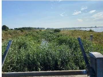
Figuur 3a en 3b: afvoerkanaal bovenstrooms
