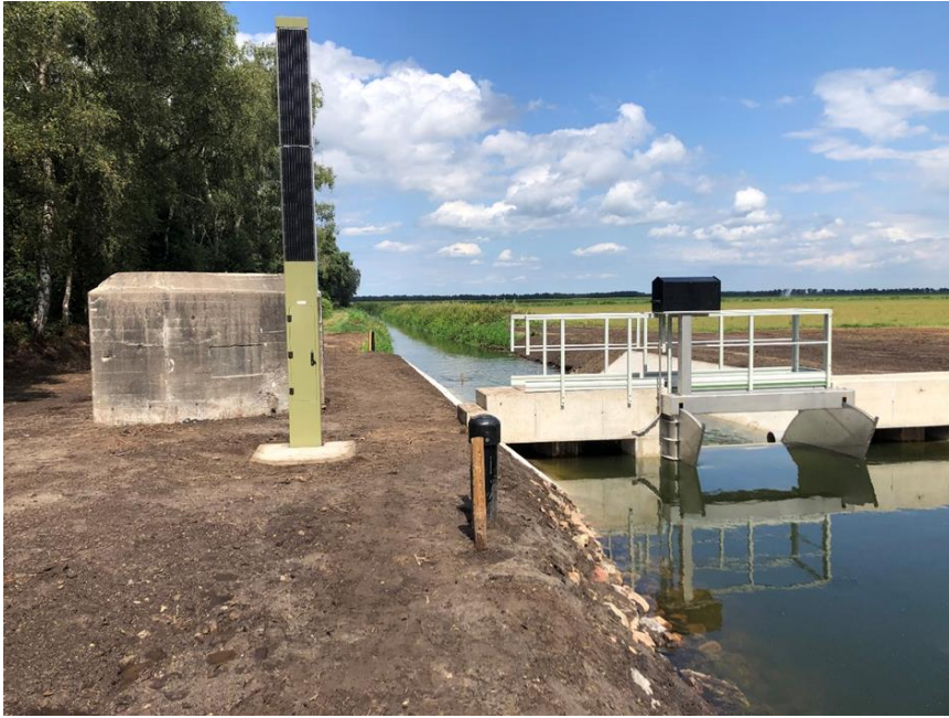
Figuur 4: Voorbeeld van kolomkast met zonnepanelen
