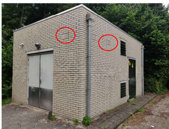
Figuur 5.1 De locaties van de openstootvoegen. Boven: Enkele ramen waarboven openstootvoegen aanwezig zijn. Linksonder: De openstootvoegen op de elektriciteitscabine (rood omcirkeld). Rechtsonder: De rij van vijf openstootvoegen boven een raam (rood omcirkeld).
