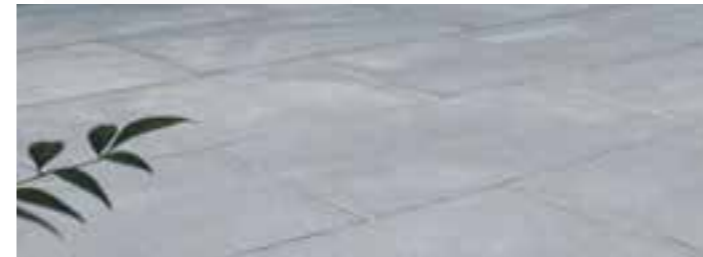
Referentie : Betontegels 40x60 cm op terrassen
