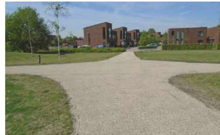
Referentie : Asfaltpad met split toplaag voor 'natuurlijke uitstraling'
