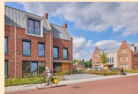
Prefab circulaire flexwoningen
