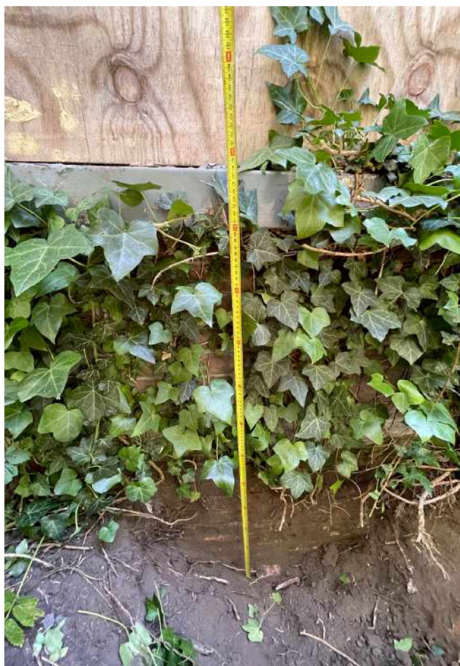
Meting aanlegdiepte fundering
