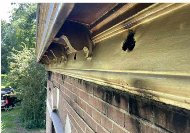
Geprofileerde daklijst met geprofileerde klossen
