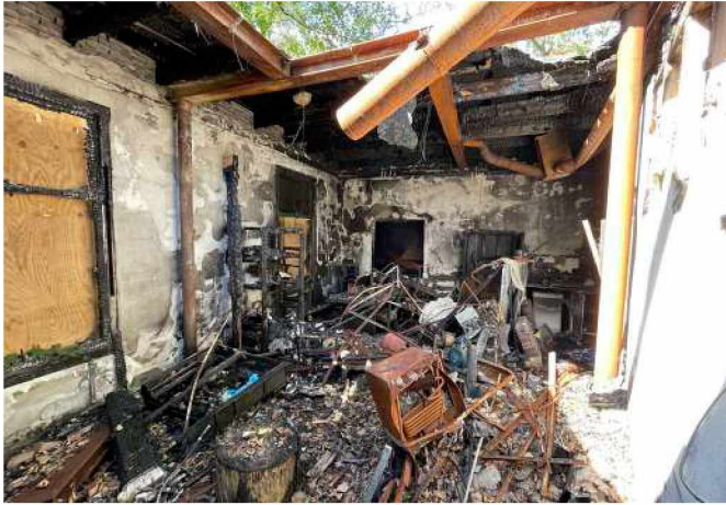
Verwongen stalen ventilatiebuizen
