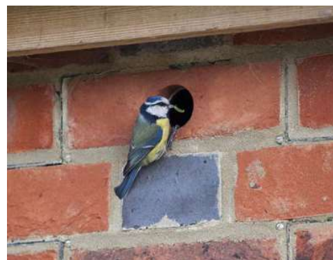
Geïntegreerde vogelnestkast (foto Bird Brick Houses Ltd)
