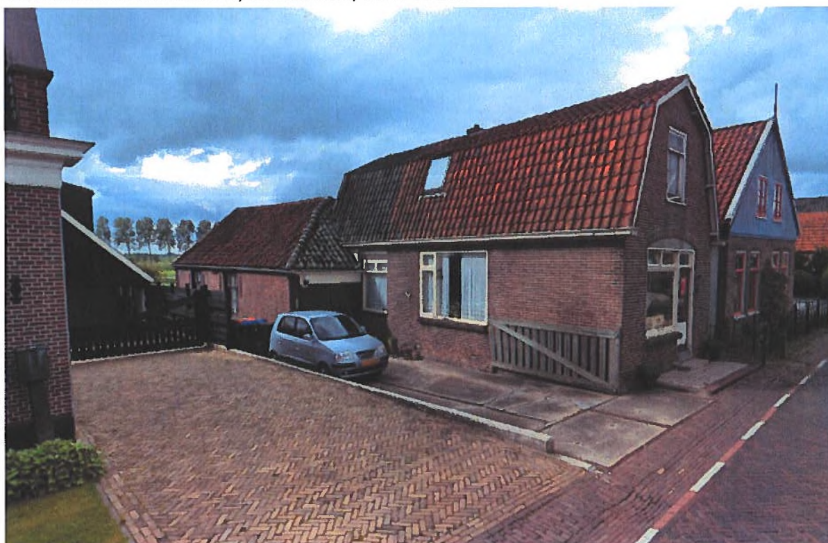
Afb.2: Aanzicht van het pand aan het westeinde 46 te Schermerhorn
