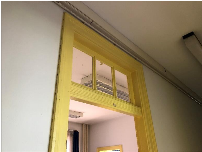
Origineel binnendeurkozijn met bovenlicht
