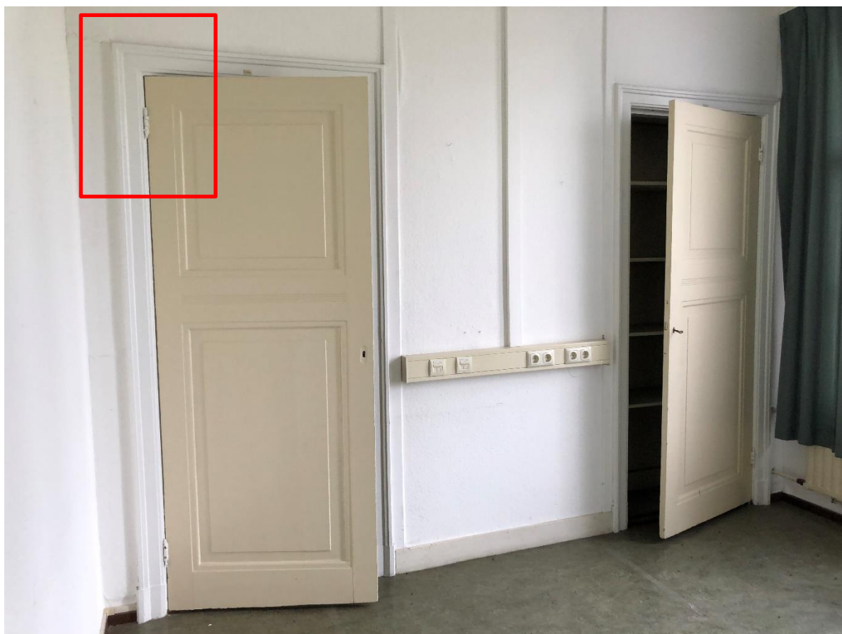
Aanzicht wand met muurkasten en centrale schouw
