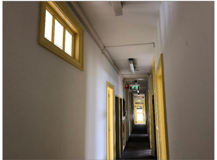
Bovenlicht in gangwand 2 de verdieping
