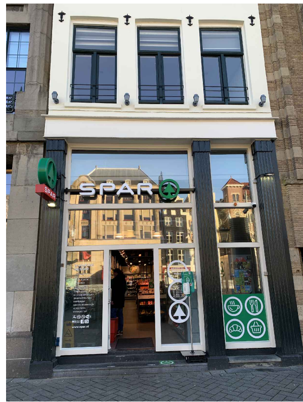
Foto's van de bestaande voorgevel
