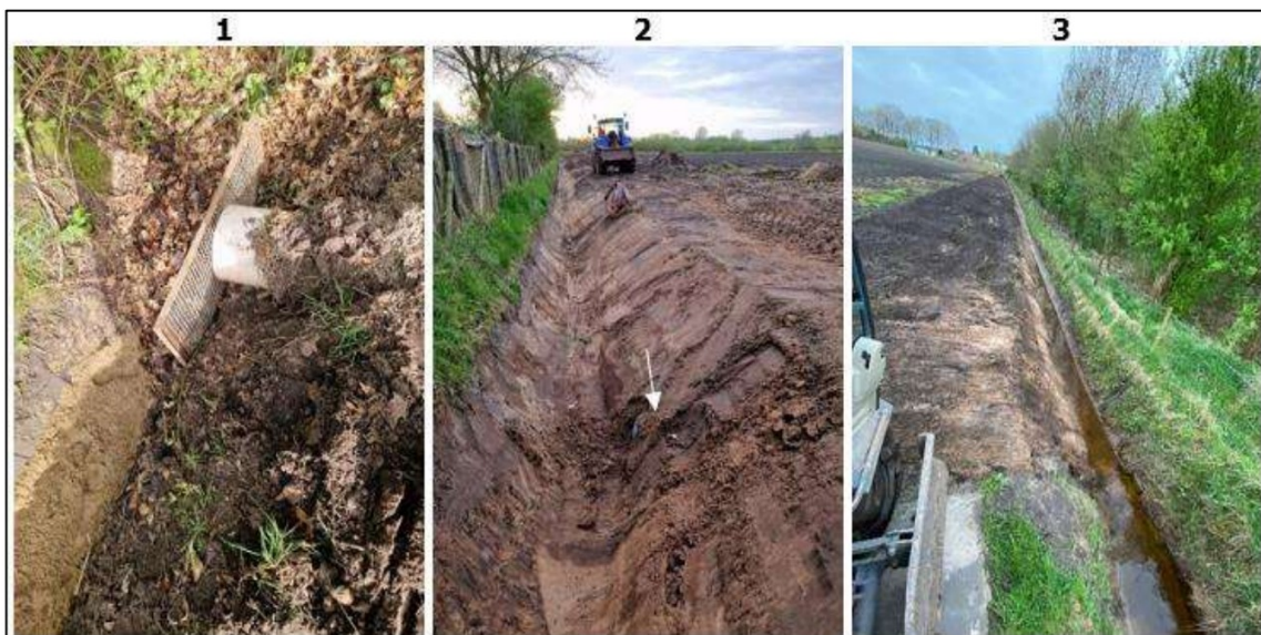
Afbeelding 2: Foto's uitgevoerde werken (april 2024)
