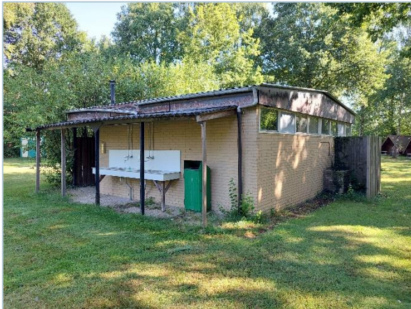
Foto 9: afdak afwasplaats (daklijn C1)
