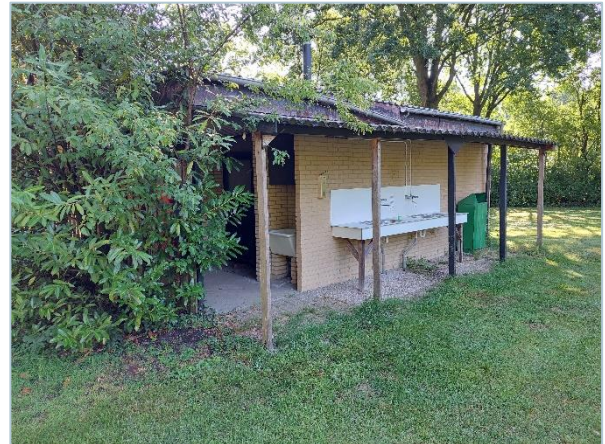
Foto 10: afdak wasplaats (daklijn C1)
