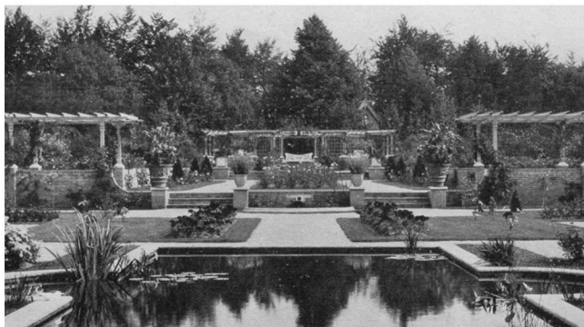
Referentie gemetselde vijvers rond 1925 (Vijverhof)
