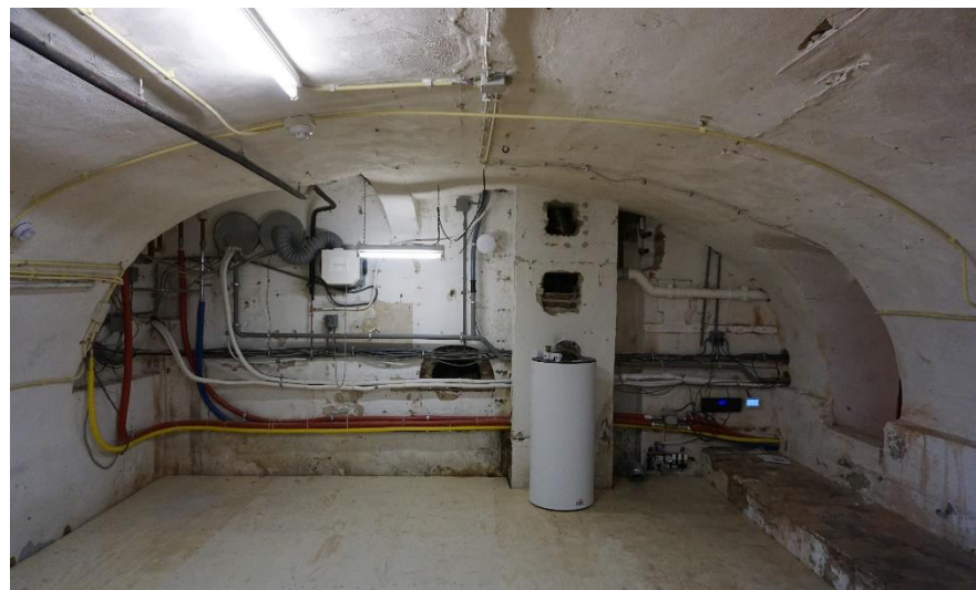
Oostelijke kelder naar het zuiden gezien
