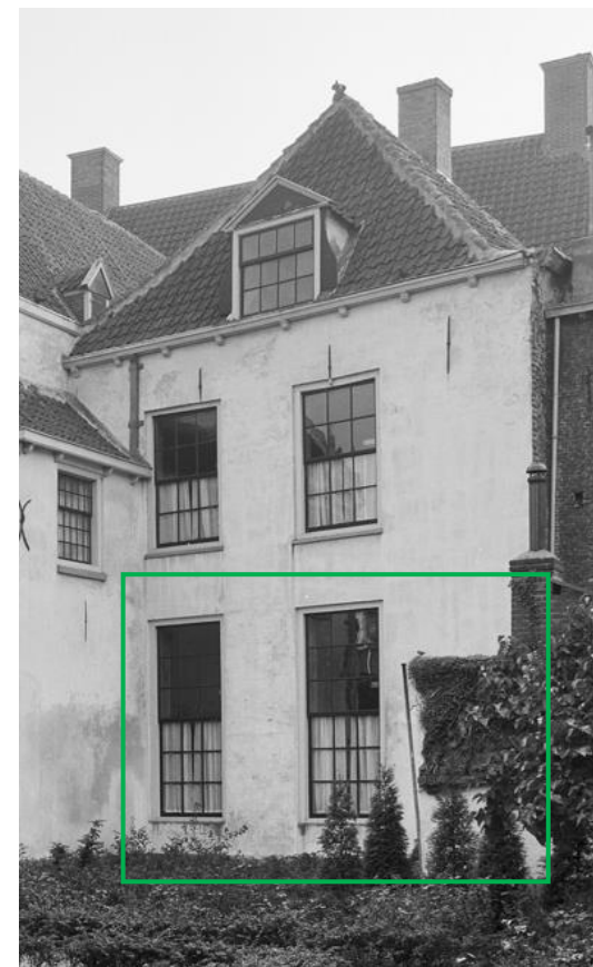
Diezelfde noordgevel van bouwdeel A in 1965 - na de restauratie van 1959-1962 (RCE 102446)
