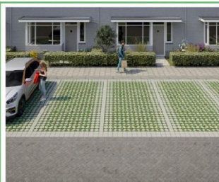
Grasbetontegels ter plaatse van parkeervakken t.b.v. infiltratie van hemelwater
