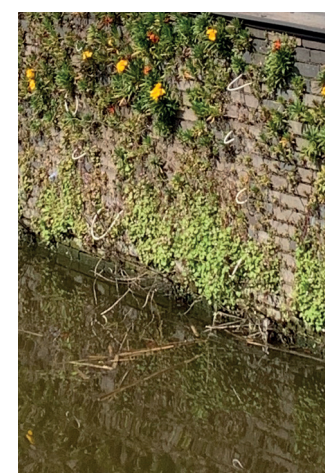
Een natuur-inclusieve kademuur proefopstelling TU Delft
