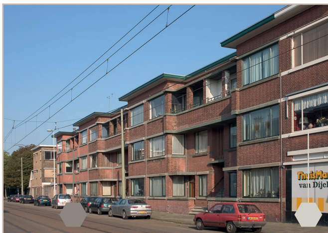
Nieuwe Haagse school architectuur, rode baksteen, Loudonstraat
