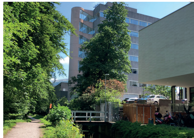
Bossloot ter hoogte van het Zandvliet College, nr.50-58 en de SER
