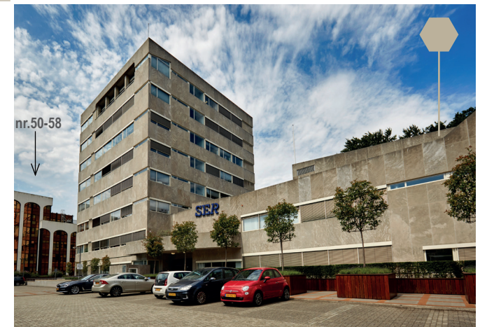
Het SER-gebouw naast nr.50-58, zandkleurig natuursteen
