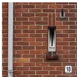
BLIND GEDETAILLEERD KOZIJN
