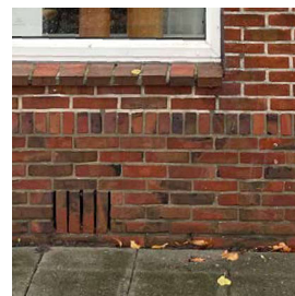
TRASRAAM MET ROLLAAG
