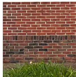
TRASRAAM MET ROLLAAG
