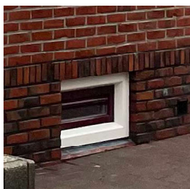
KELDERRAAM ONDER ROLLAAG
