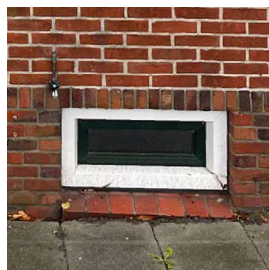
KELDERRAAM ONDER ROLLAAG
