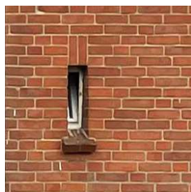
BLIND GEDETAILLEERD KOZIJN
