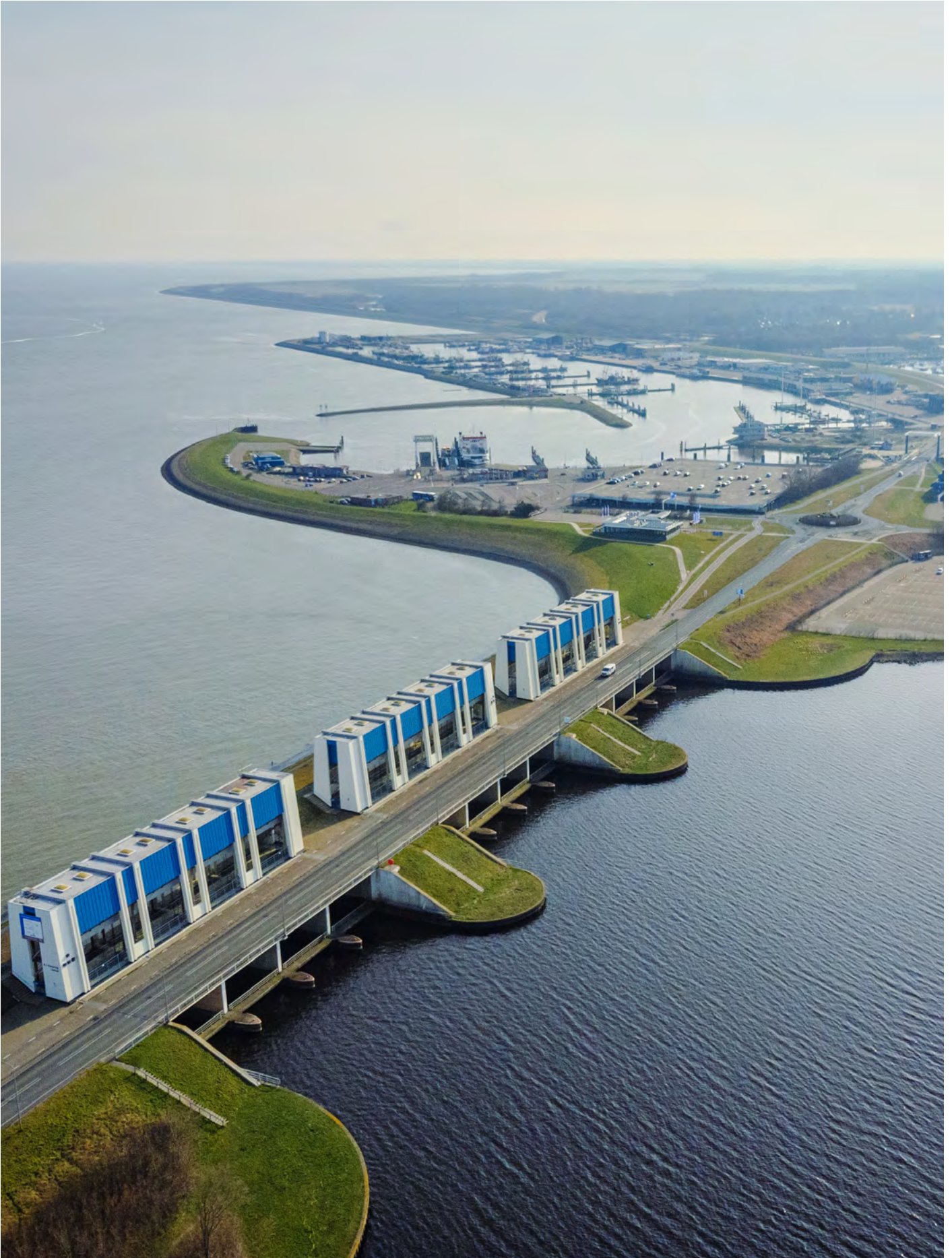
De R.J. Cleveringsluizen, het spuisluizencomplex bij Lauwersoog
