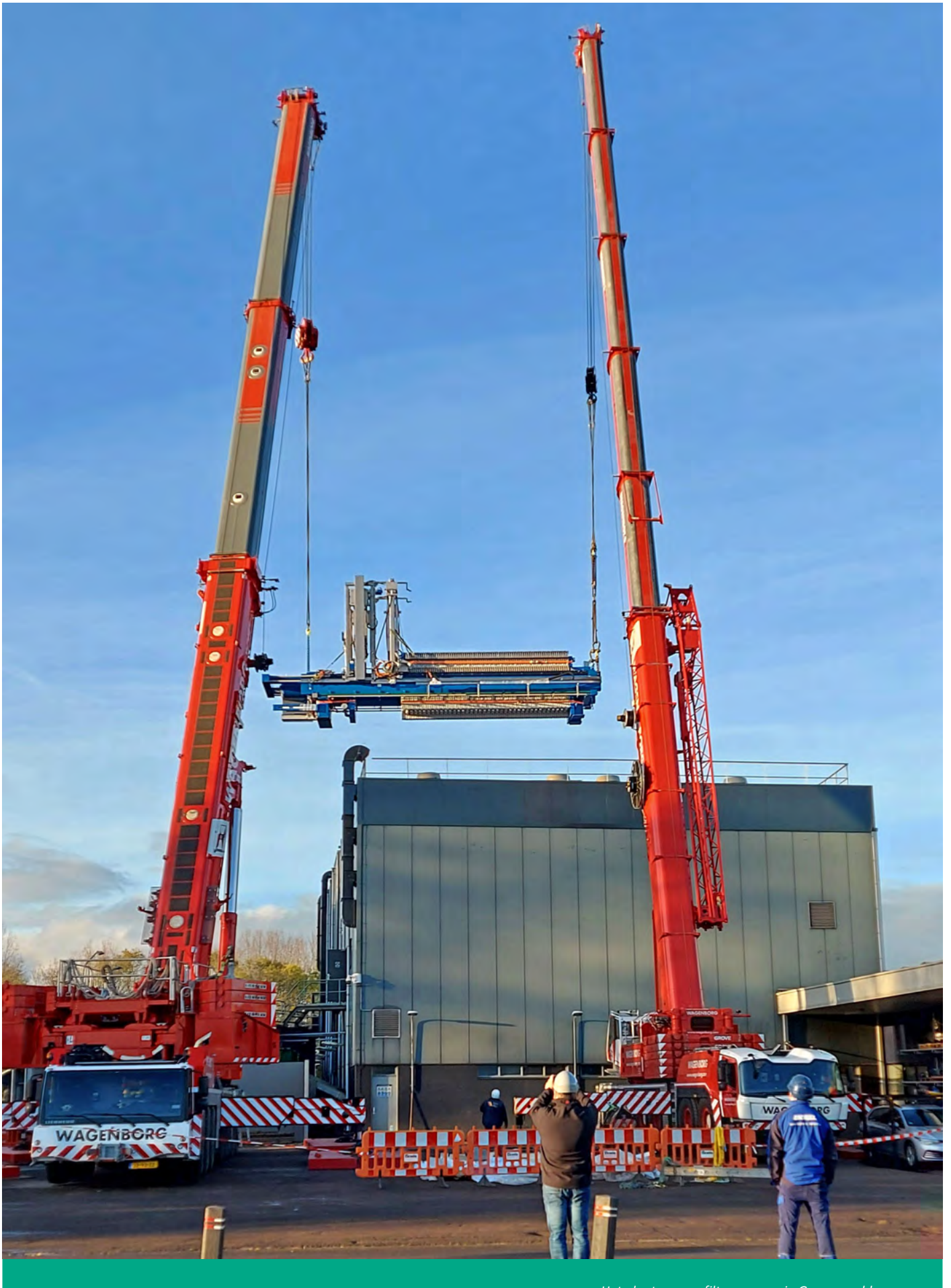
Het plaatsen van filterpompen in Garmerwolde
