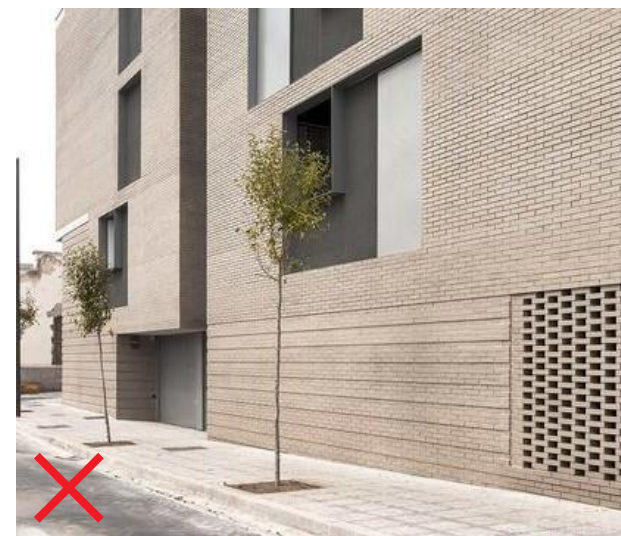
Parkeergarage in de plint
