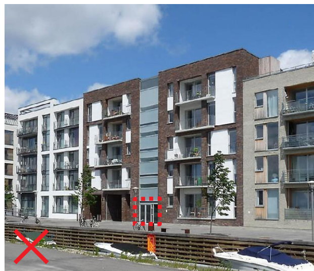
Twee (ogenschijnlijk) aparte huizen delen een entree
