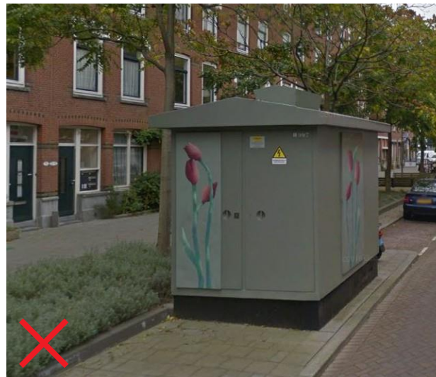
Transformatorhuisje in de openbare ruimte
