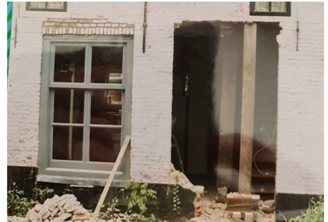
1991 plaatsen 3 nieuwe kozijnen in linker zijgevel
