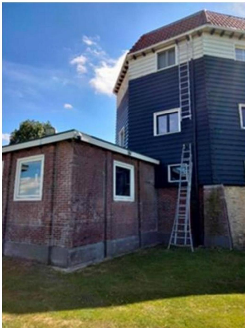
Afb. 23, noordz, achter de ladder, recente muur.
