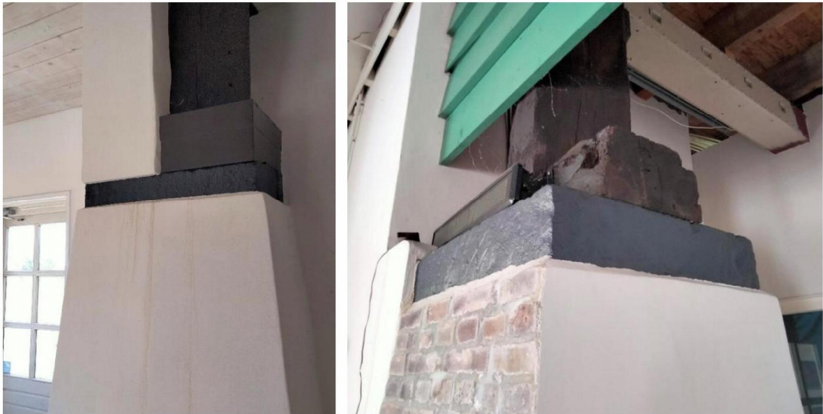
Afb. 33 en 34, molenvoet met peulstenen (hardsteen) en resten van het ondertafelment, zuidzijde, niveau 1.
