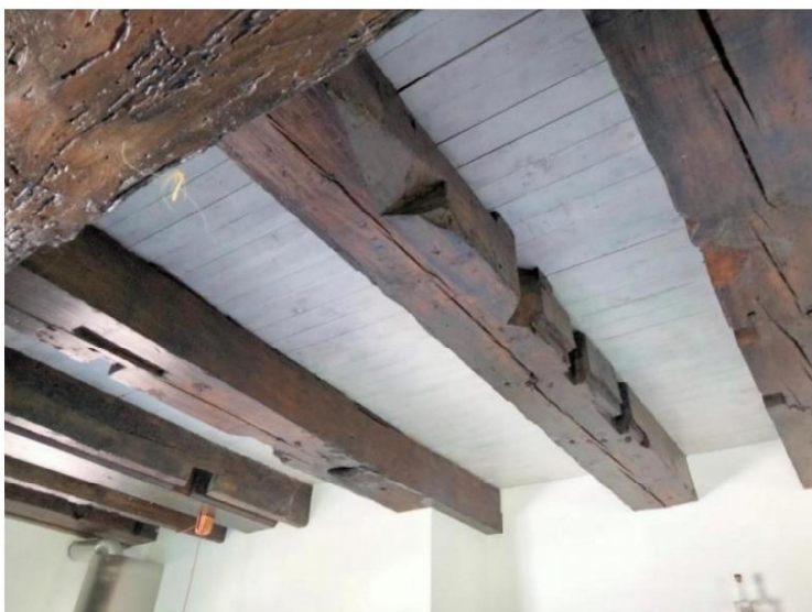
Afb. 43, zoldering op niveau 5, bouwsporen.
