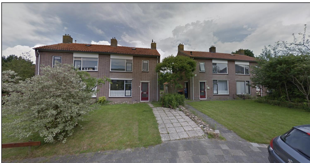
Afbeelding 2.2 Straatbeeld huidige situatie (Bron: Google Streetview)
