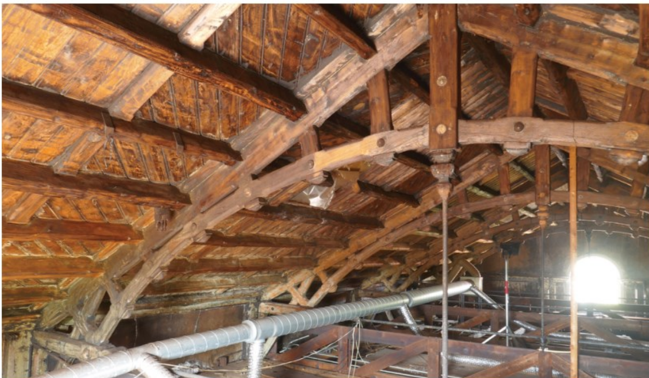
Afb. 4.35 Overzicht van het eerste (van vier) spant nabij de achtergevel. De constructie met gebogen stijl onder de spantbenen is goed zichtbaar.
