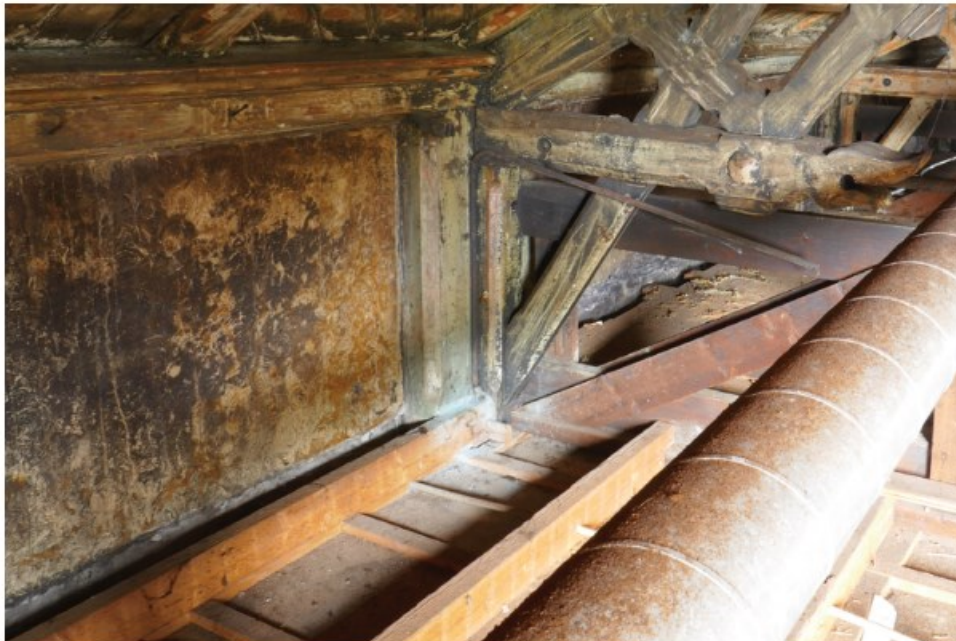
Afb. 4.34 De borstweringen (oorspronkelijk slechts de bovenzijde van de zijmuren) zijn afgewerkt met een pleisterlaag met krullen (met eveneens veel rookschade). Ook is rechts één van de gedecoreerde blokkeels te zien.
