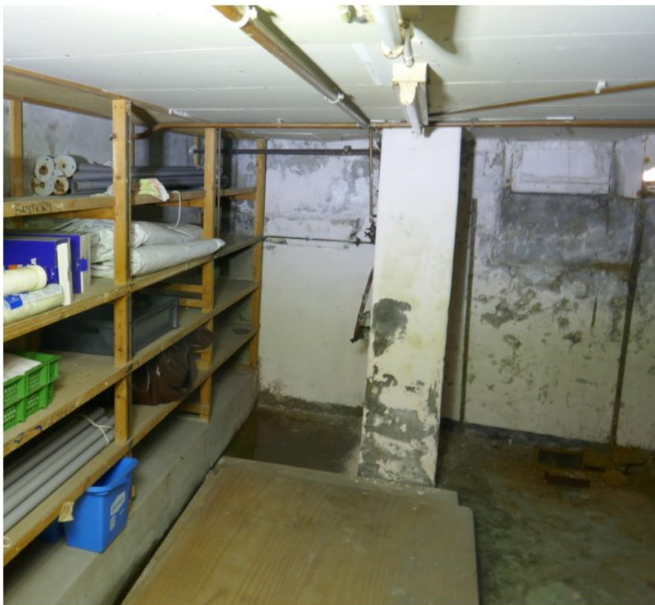
Afb. 4.10 Foto ruimte -1.01a, gezien richting de Kalverstraat (rechts is onder het plafond een dichtgezet buitenvenster zichtbaar). De (sub-)recent aangebrachte interieurafwerkingen op vloer, muren en plafond zijn goed zichtbaar.
