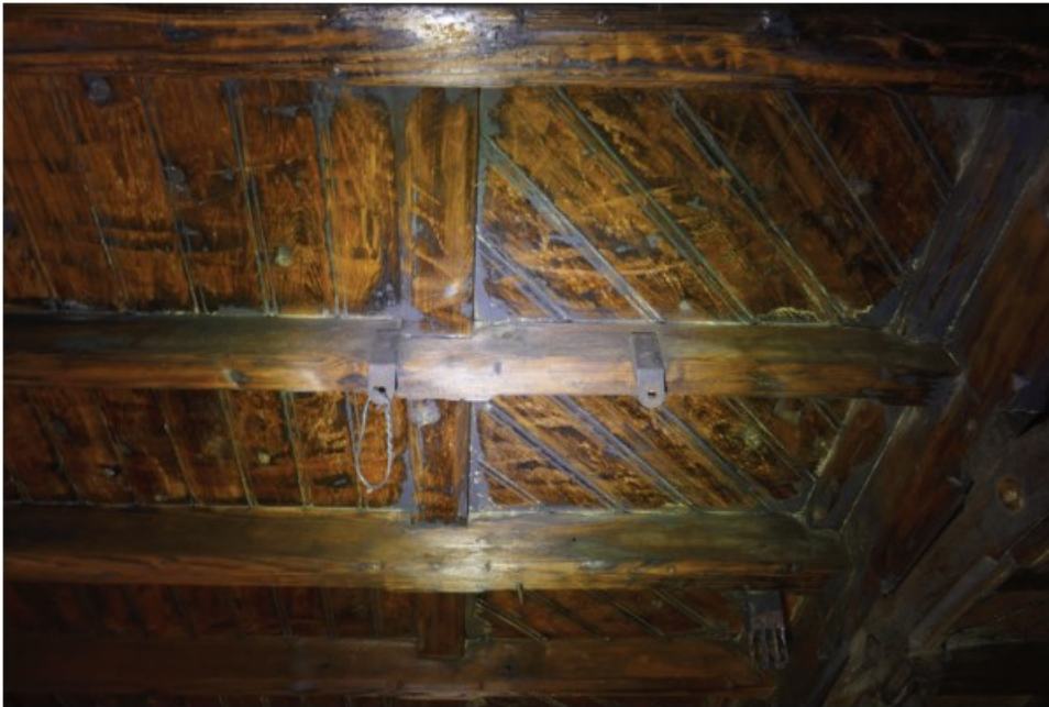
Afb. 4.39 Foto van het dakbeschot, dat bestaat uit kraaldelen die in een decoratief patroon (afgewisseld schuin en verticaal) zijn geplaatst. N.B.: ook hier is rookschade goed zichtbaar.
