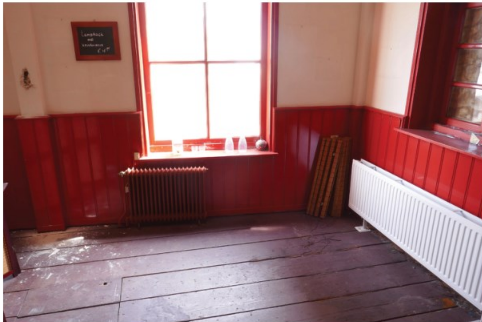
Afb. 4.25 Foto van het achterste raam van ruimte 1.01 (de achtergevel is rechts). Het glas is (sub-)recent vervangen en mogelijk geldt dat voor het gehele venster, gezien de flinke brand die hier in 1976 gewoed heeft.
