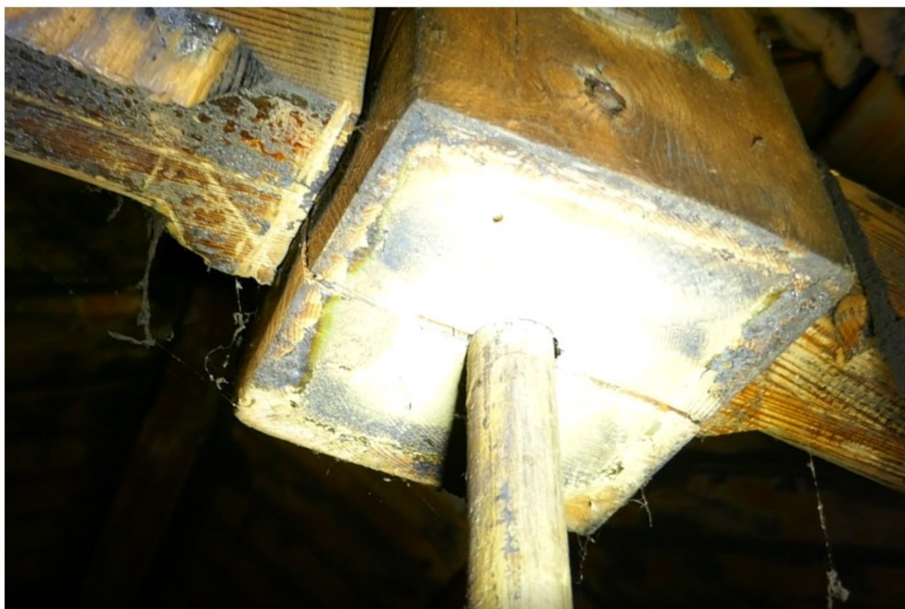
Afb. 4.38 Bij het derde spant (vanaf de achtergevel; de zolder was hier nog maar zeer beperkt begaanbaar) ontbreekt de decoratieve onderzijde van de makelaar. Duidelijk zichtbaar is dat deze (en de naastliggende gebogen stijlen) uit twee helften bestaan, en de verticale stang omklemmen.
