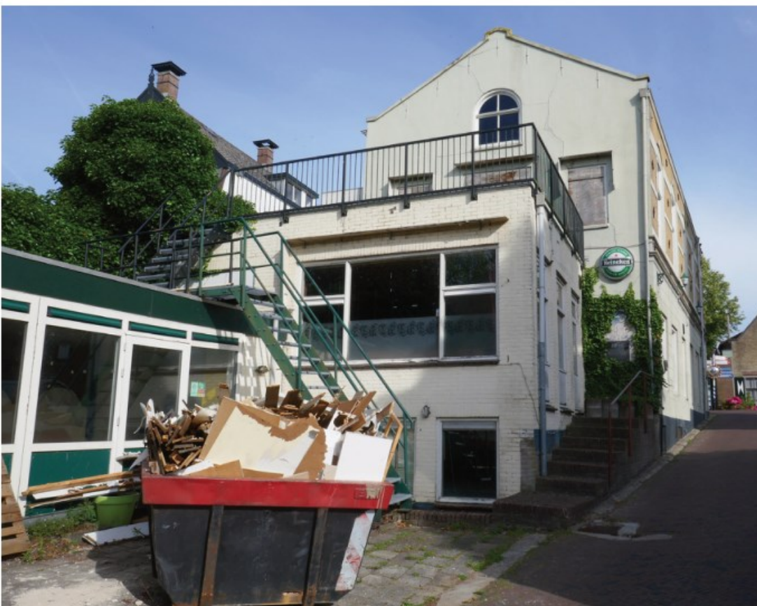
gezien vanuit het zuidoost (achtergevel met de lagere aanbouwen)
