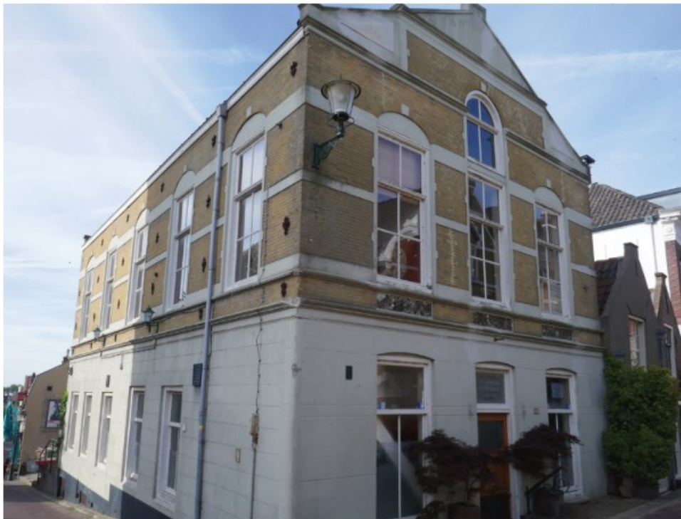
Afb. 4.2 Foto van de voorgevel. De vastgelegde toestand komt nog vrijwel geheel overeen met de situatie in 1973 (en zelfs die in 1922; zie afb. 3.12).
