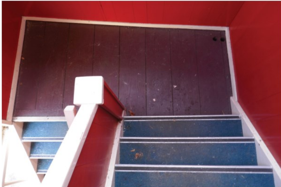
Afb. 4.28 Foto van trappenhuis 1.01a, gezien vanaf de 1e verdieping. Duidelijk zichtbaar zijn de twee rechte trappen met het tussenliggende bordes. Tevens is goed zichtbaar hoe het pand niet geheel rechte hoeken heeft.
