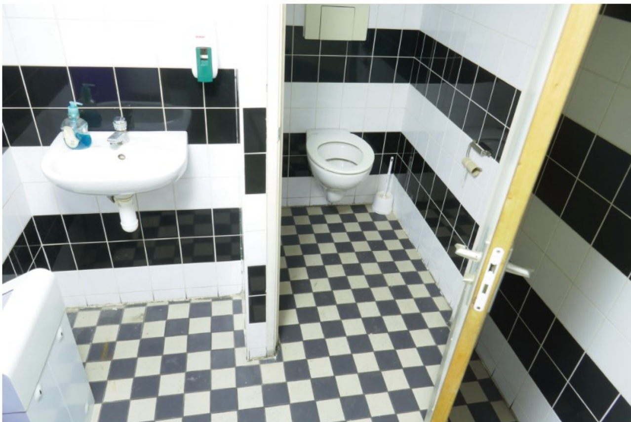
Afb. 4.23 Foto van toilet-ruimte 0.04b. De zichtbare afwerkingen van deze (sub-) recent ingebouwde ruimte zijn vrijwel gelijk aan die in het herentoilet 0.04c.
