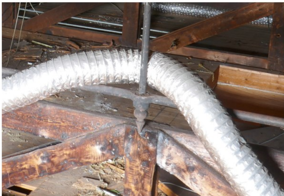
Afb. 4.38 Bij het derde spant (vanaf de achtergevel; de zolder was hier nog maar zeer beperkt begaanbaar) ontbreekt de decoratieve onderzijde van de makelaar. Duidelijk zichtbaar is dat deze (en de naastliggende gebogen stijlen) uit twee helften bestaan, en de verticale stang omklemmen.
