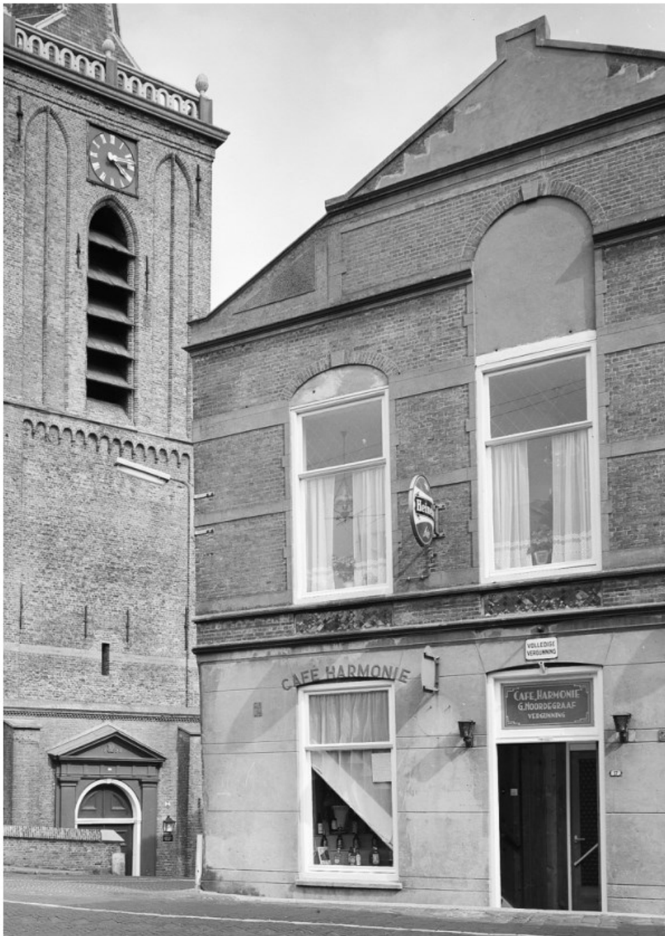
Afb. 3.12 In 1973 werd een foto van de voorgevel gemaakt vanuit vrijwel dezelfde hoek als die uit 1922 (zie afb. 3.9; links is deze ter vergelijking herhaald). De diverse wijzigingen die in de tussenliggende 50 jaar aan het pand werden aangebracht zijn goed duidelijk. Let bijv. ook op de ruit boven de voordeur (nu met andere naam) en de vervangen trap links achter de voordeur, die nu zelfs het linkerraam grotendeels blokkeert. RCE inv.nr. 152152
