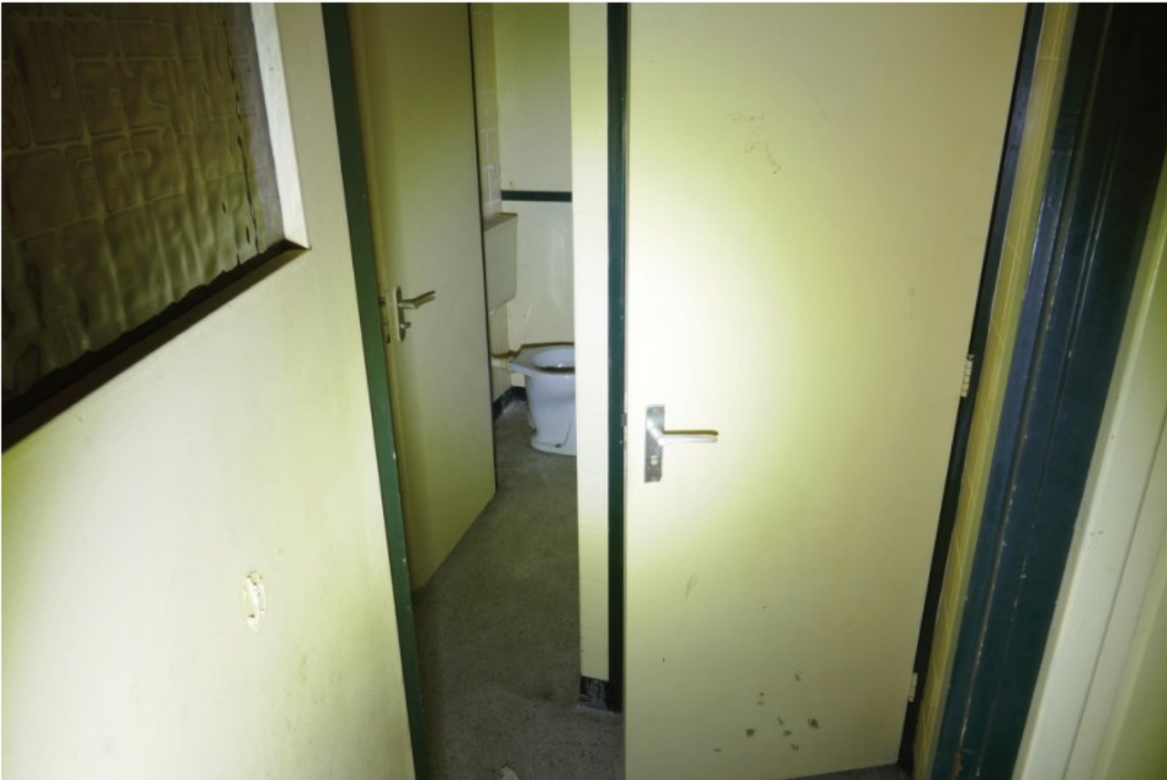
Afb. 4.13 Foto van toilet -1.04, dat tussen 1964 en 1972 moet zijn aangelegd. De afwerkingen zijn alle (sub-)recent en stammen mogelijk nog uit die bouwtijd.
