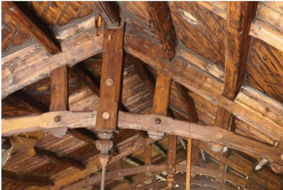
Afb. 4.36 De spantbenen komen bovenin samen in een makelaar. Die bestaat zelf (net als de gehele gebogen stijl; zie afb. 4.38) uit twee helften die een verticale metalen stang (onderaan zichtbaar) omklemmen; deze stang ondersteunt een horizontale, metalen trekstang.
