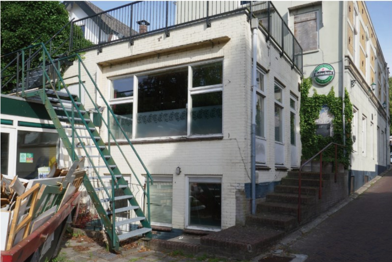
Afb. 4.7 Foto van de achterzijde, waar de aanbouw uit 1972 (ruimte 0.02) duidelijk zichtbaar is. Let links op de metalen, groene trap die over de snackbar 0.03 naar het platte dak van 0.02 leidt.
