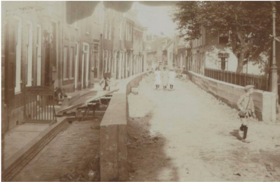
Afb. 3.20 Foto van enige tijd na de ramp van 1916 (zie 3.19). De watersnood heeft geresulteerd in de hier zichtbare oplossing: op de weg worden twee hoge, betonnen randen geplaatst, waarna het wegdek (en daarmee het dijklichaam) wordt verhoogd. Deze betonnen elementen zijn tot op de dag van vandaag in de dijk zichtbaar. SAMH 0440_69760
