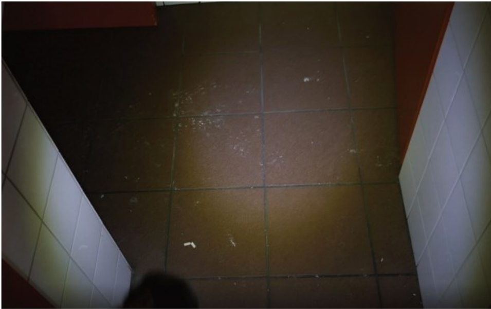
Afb. 4.31 Foto (enigszins donker) van toilet 1.04, gezien vanuit de doorgang vanuit 1.01. De vloer- en wandbetegelingen zijn goed zichtbaar.
