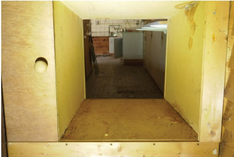
Afb. 4.12 De snackbar -1.03 staat in verbinding met de rest van de kelder door middel van een klein doorgeefluik. De snackbar (door het luik zichtbaar) is verder niet onderzocht.
