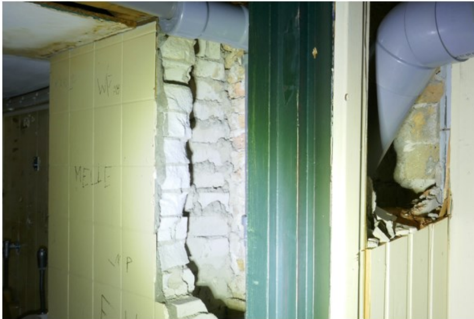
Afb. 4.9 Foto van de wand tussen -1.04 (links) en -1.01. De betegeling links is op een wand uit van witte kalkzandsteen aangebracht (waarschijnlijk uit 1964/67). Rechts daarvan (links van de groene deurpost) is een smalle strook oud metselwerk te zien, dat waarschijnlijk tot 1882 teruggaat. Aanwijzingen voor ouder, opgaand muurwerk binnen het gebouw zijn niet aangetroffen.
