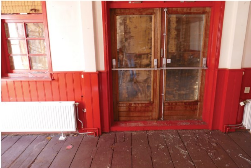
Afb. 4.26 Foto van de deur en een venster (links) in de achtergevel. De deur werd tussen 1972 en '77 ingebouwd. Ook de roedes in de vensters (rechts van de deur zit er ook een; zie 4.24) werden in 1977 ingebracht; mogelijk werd daarbij ook enige brandschade weggewerkt.
