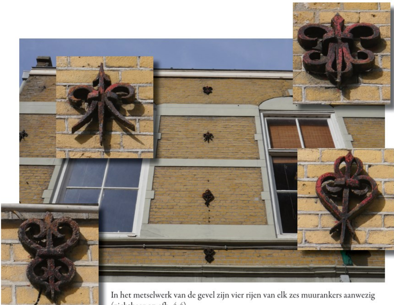
Afb. 4.5 Detail van de zijgevel aan de Kalverstraat; hier zijn een reeks muurankers aanwezig (vier verticaal maal zes horizontaal). De ankers in elk van de vier rijen kent een iets andere vormgeving (zie inzetten).
