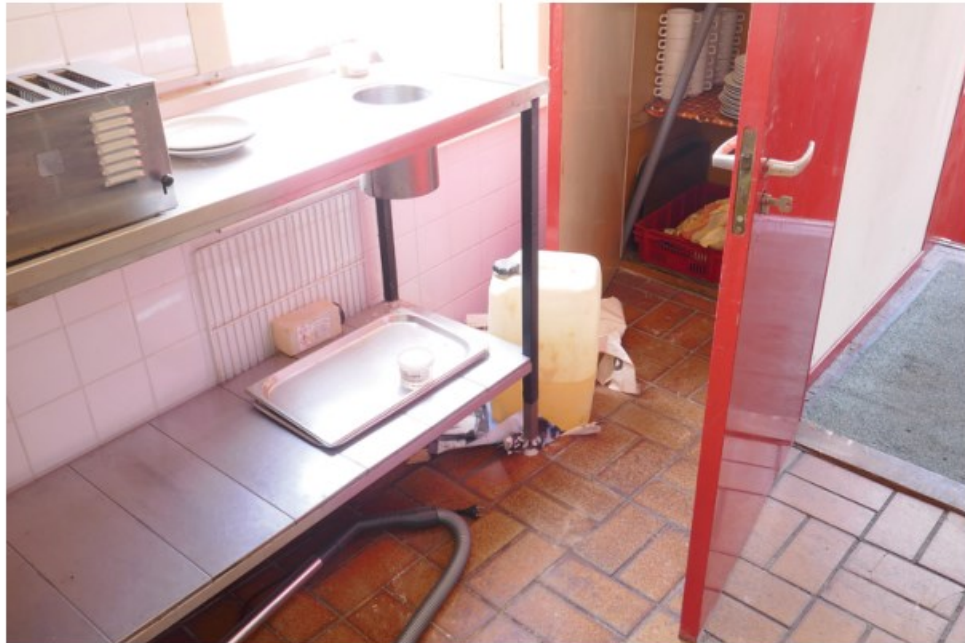
Afb. 4.30 Foto van keuken 1.01b, gezien in grofweg dezelfde richting als 4.29. Links van de deur is een kleine inbouwkast te zien, die deels bóven de trap 1.01a hangt. De vloer- en wandtegelingen zijn goed zichtbaar.
