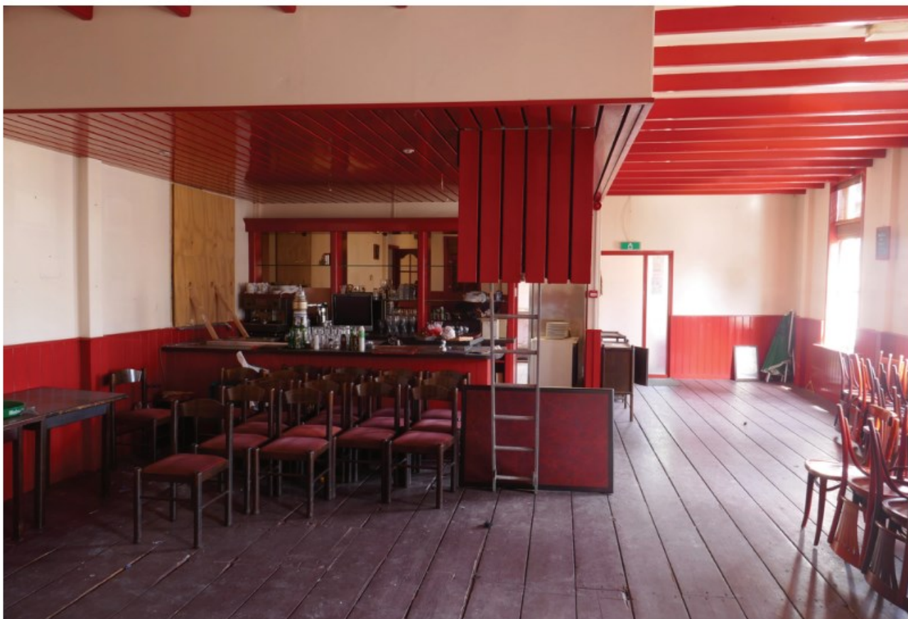
Afb. 4.27 Foto van ruimte 1.01, gezien richting de voorgevel. Links is duidelijk het bar-gedeelte zichtbaar dat zich ook nog eens van de rest van de ruimte onderscheidt door een lager plafond-gedeelte. Links van de bar (in de buitenmuur) is een venster aanwezig dat met een multiplex plaat is afgedekt.
