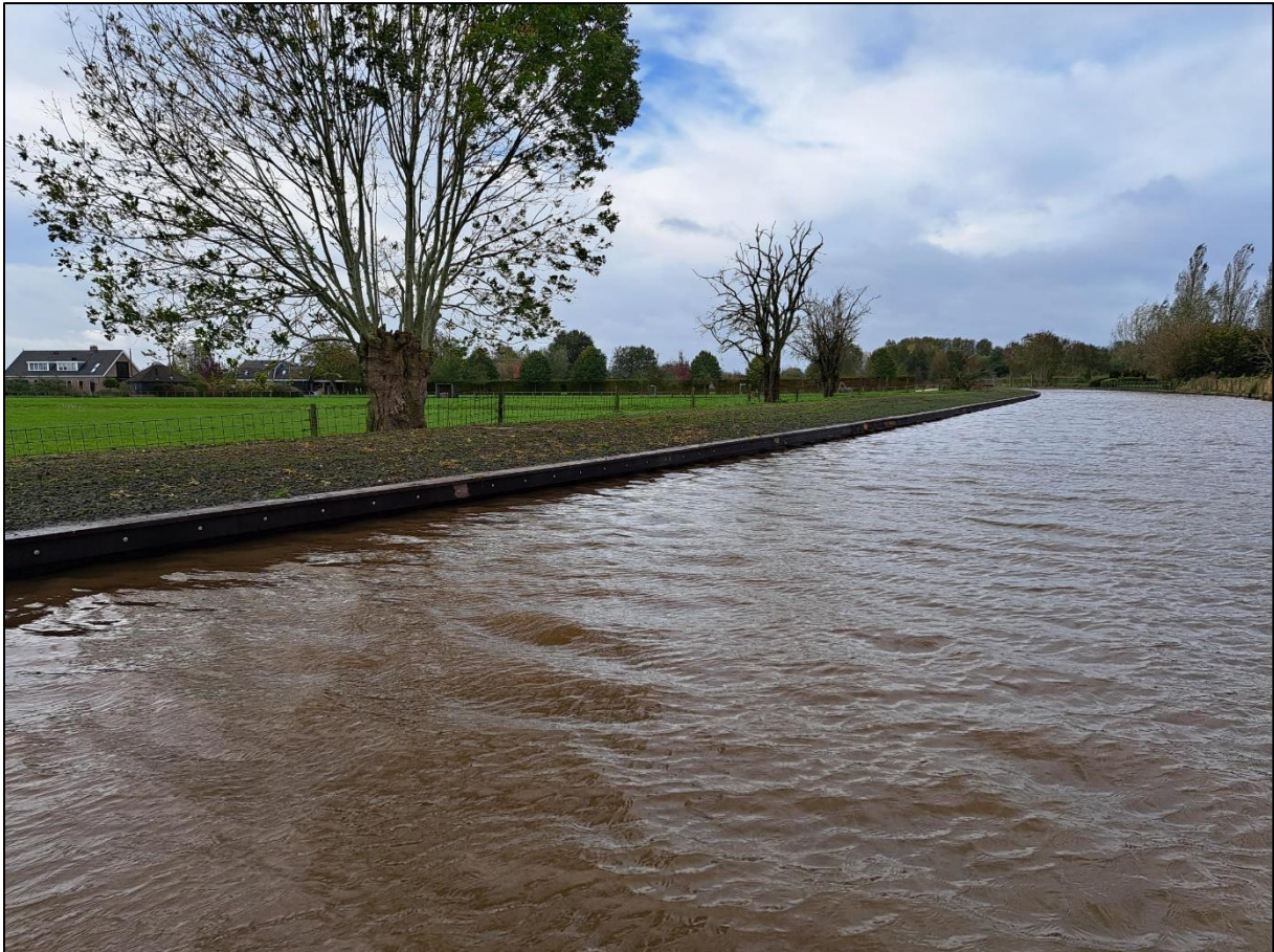
Figuur 3 Een lage houten damwand zoals aangelegd op een ander deel langs de GHIJ.
