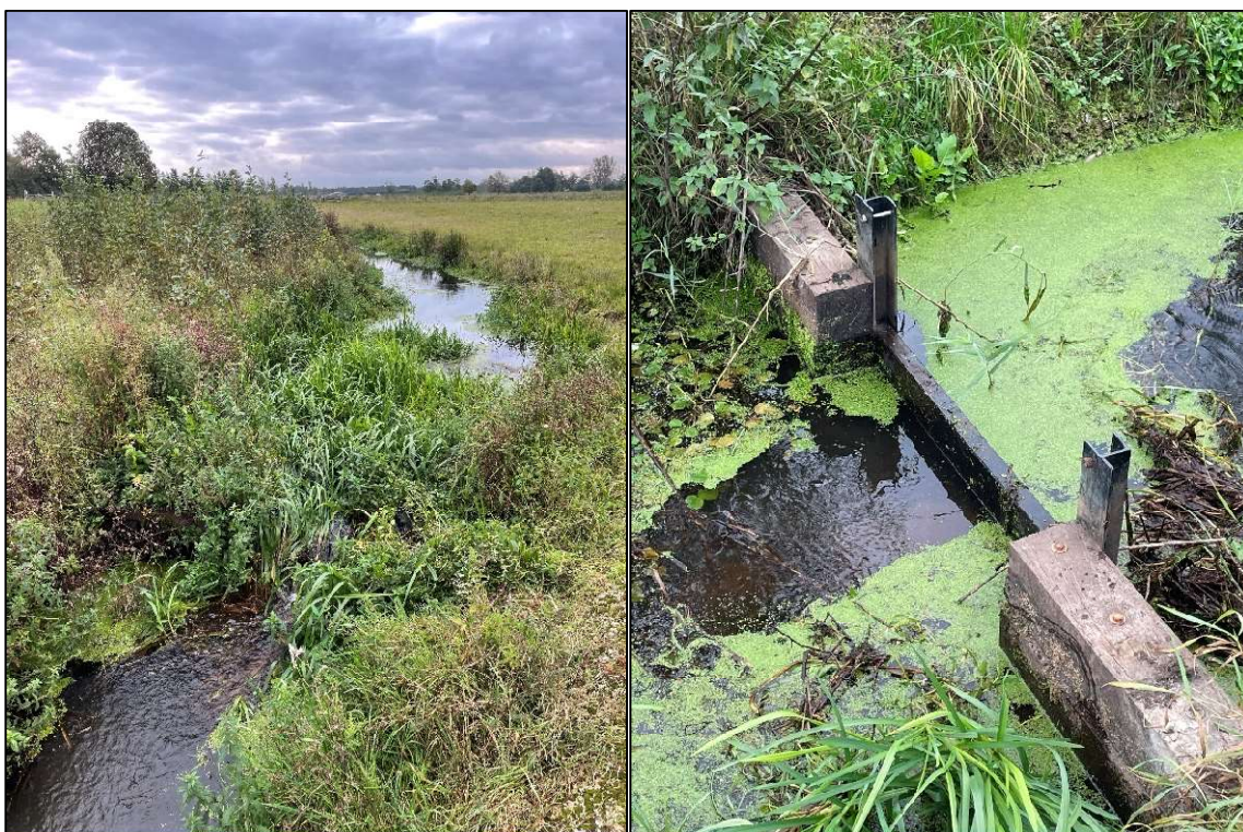
figuur 3.1 Vispassage Entermors in de huidige situatie.
