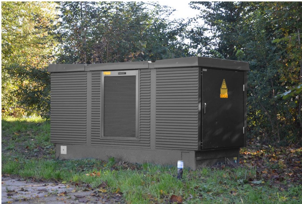
Afbeelding 15. Referentie: transformator, Diabolo 5HL grijs, bron: alfen.com.
