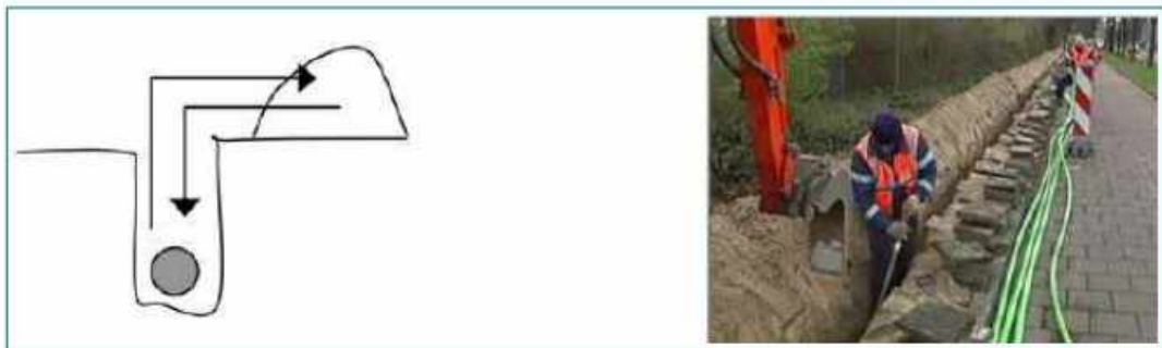
Figuur 9: werkzaamheden aan kabels en leidingen
