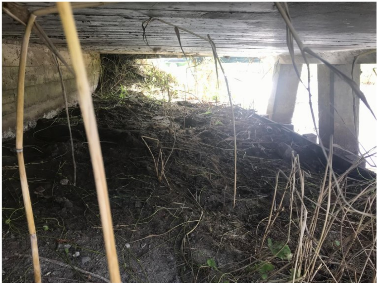
Afbeelding 12. Brug met ruimte onder het brugdek waar otters schuilplaatsen kunnen hebben.
