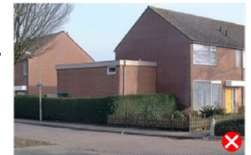
zijaanbouw te hoog
