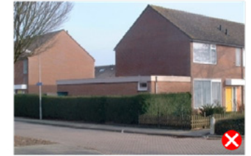
zijaanbouw te dicht bij voorgevelrooilijn
