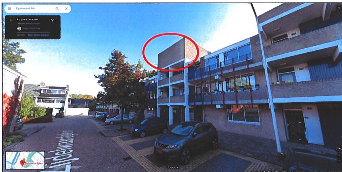
Figuur 2: Weergave van de gevel waar het kraamverblijf zit in bevindt. Bij dit blok zal spouwmuurisolatie achterwege gelaten worden.
