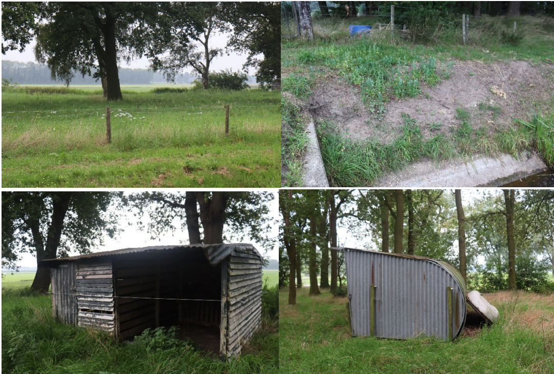
Figuur 12: Foto's terreininspectie
