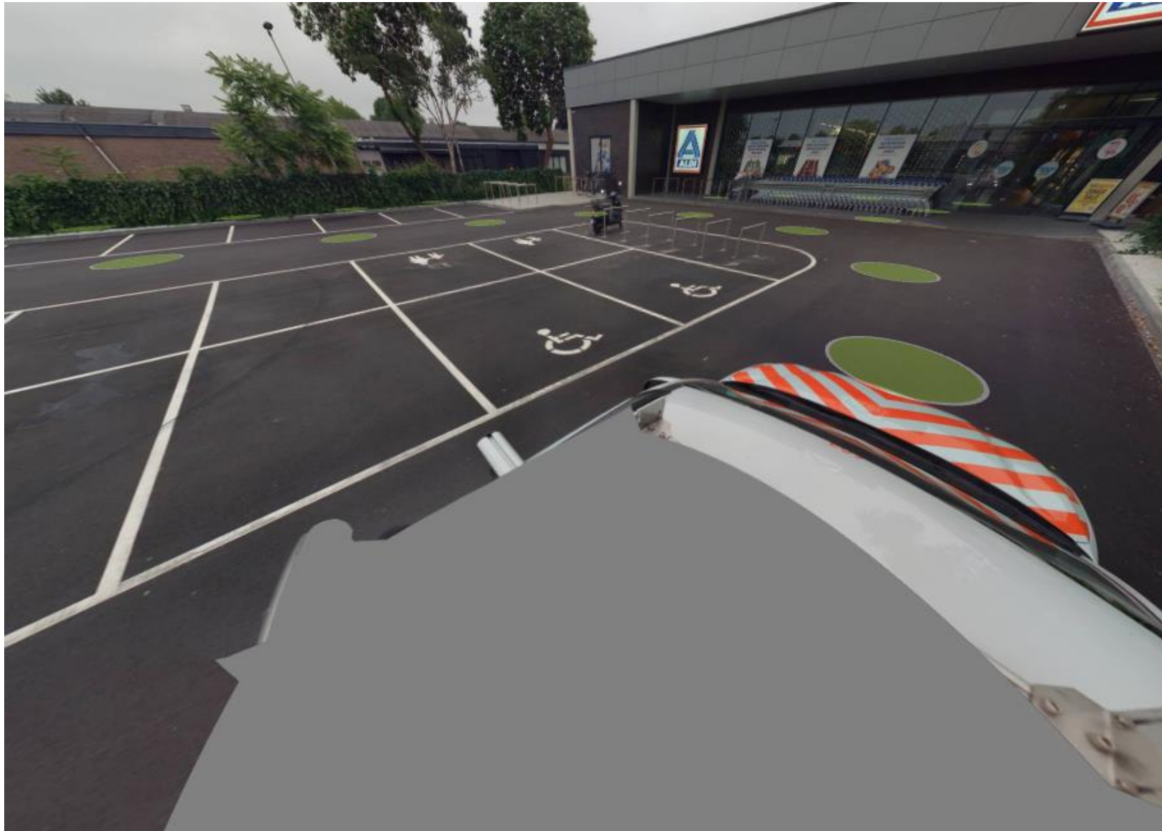
parkeerterrein Aldi, Jan de Rooijstraat te Kaatsheuvel
