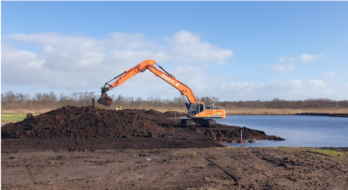
Figuur 5.1a: Natuurontwikkeling Weimeren fase 1. De bovengrond wordt in depot gezet ten behoeve van verbetering kering Weimeren. Het veen dat vrijkomt wordt in depot gezet en afgevoerd.
