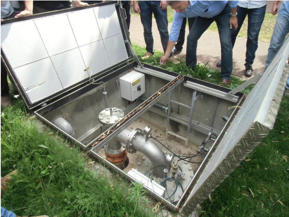
Figuur Fout! Geen tekst met de opgegeven stijl in het document.-9 Bronput van een OBES [12].
