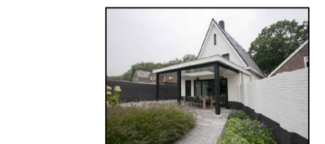
gevels metselwerk wit gekeimd
