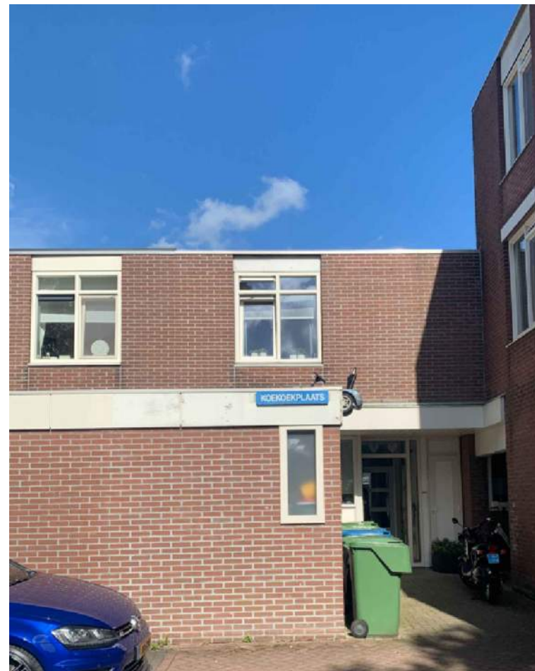
VOORGEVEL BESTAANDE TOESTAND
