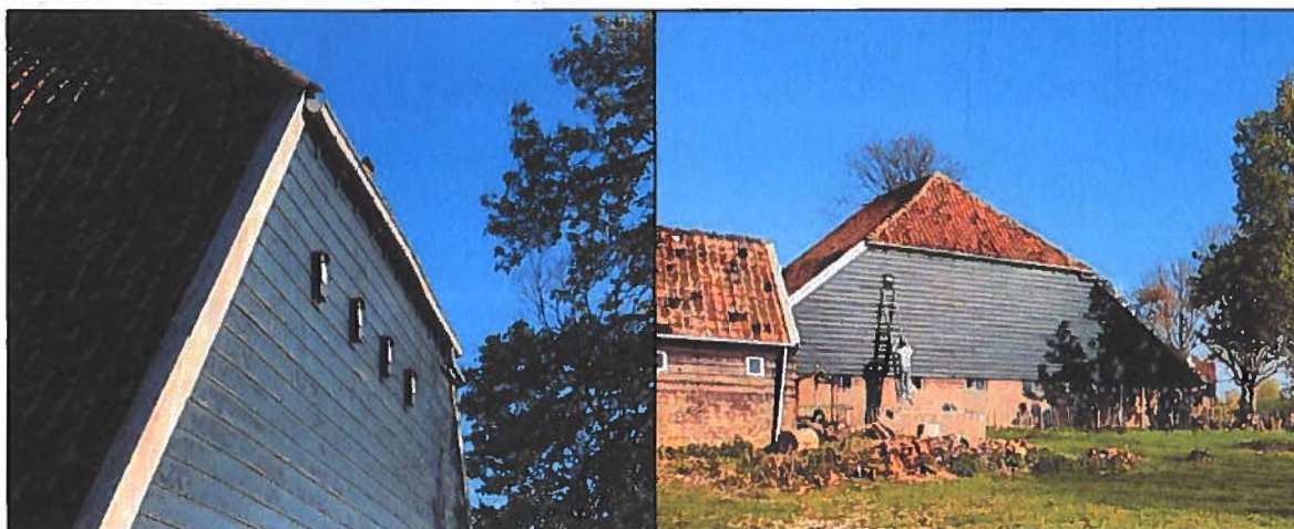
Foto 1 en 2. Locatie van de vervangende verblijfplaatsen aan de westgevel van de boerderij.
