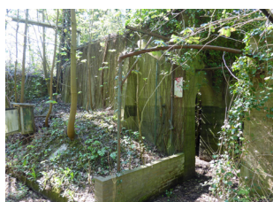
B6 Rijksmonument 1930 Beproeversgebouw
