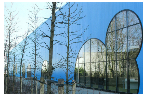
Nieuwe gevelopeningen in voormalige bedrijfshal (Carlos Arroyo, Oostkamp BE)
