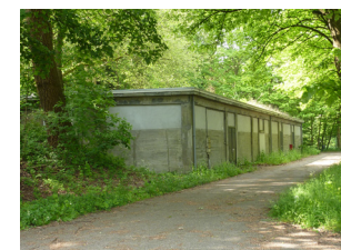
M9 Rijksmonument 1917 (verbouwd 1932) Munitiemagazijn
