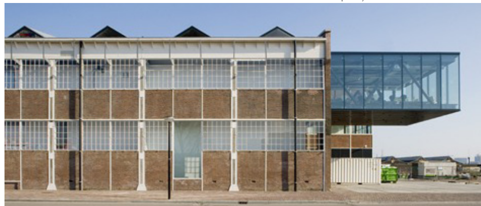
Aanbouw op hoogte (Max van Aerschot, MTV-gebouw Amsterdam)
