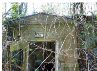
B7 Rijksmonument 1930 Beproeversgebouw
