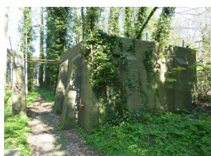
B8 Rijksmonument 1930 Beproeversgebouw
