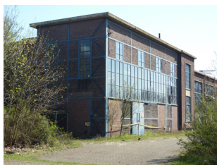
218 Rijksmonument ca. 1930 Ketelcentrale
