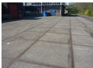
M6 Rijksmonument 1917 (verbouwd 1932) Munitiemagazijn
