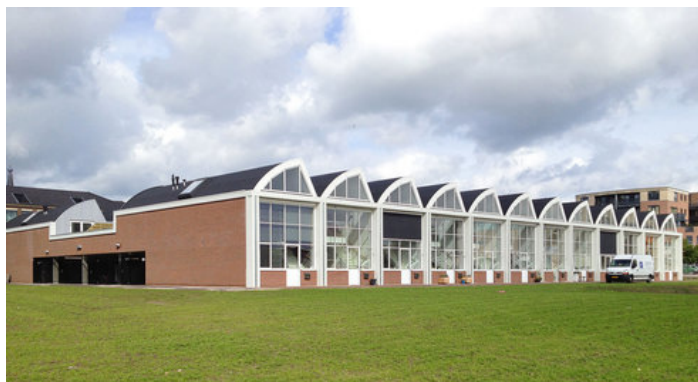
Transformatie van hal naar woningencomplex (Johan De Wachter Architects, Doetinchem)
