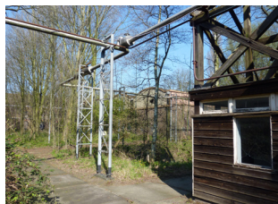
B1 Rijksmonument 1915 Sasgebouw en prepareren munitie
