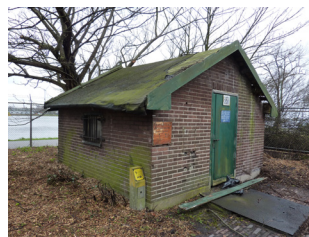
200 Gemeentelijk monument Ca. 1902 Pomphuis brandpomp
