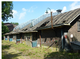
316 Rijksmonument 1936 - 1941 Was- en kleedlokaal
