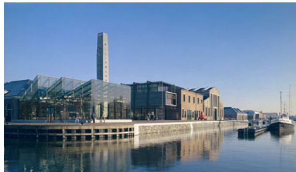
Nieuwbouw met een industrieel karakter (Rijkswerf Willemsoord, Den Helder)
