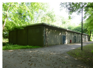
M8 Rijksmonument 1917 (verbouwd 1932) Munitiemagazijn
