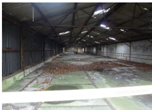
A12 Gemeentelijk monument 1916 - 1921 Magazijn wasinrichting, waslokaal en brandweer
