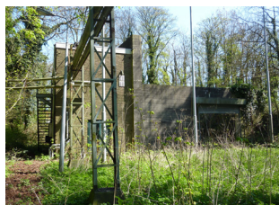
B5 Rijksmonument 1930 Productie- en beproevingsgebouw loodzide
