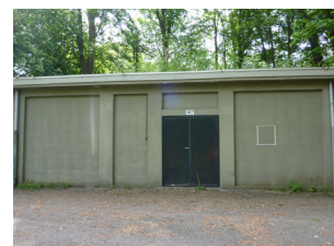
M7 Rijksmonument 1917 (verbouwd 1932) Munitiemagazijn
