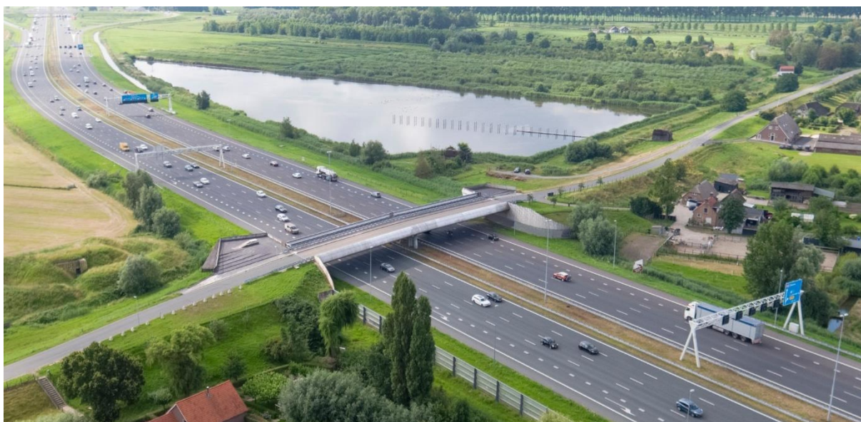
Figuur 67. Het acces in de Diefdijk dat gevormd wordt door de A2, gezien vanuit het noorden. (Rijkswaterstaat).
