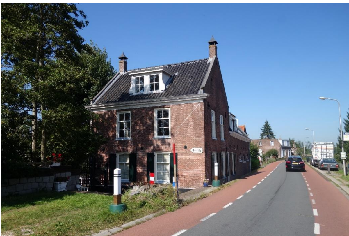
Figuur 87. Historische bebouwing aan de Lekdijk in Sluis. (MAB, 2021).
