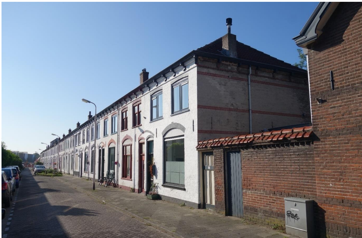
Figuur 99. Arbeiderswoningcomplex uit de vroege 20 e eeuw nabij de Leerdamse glasfabriek. (MAB, 2021).
