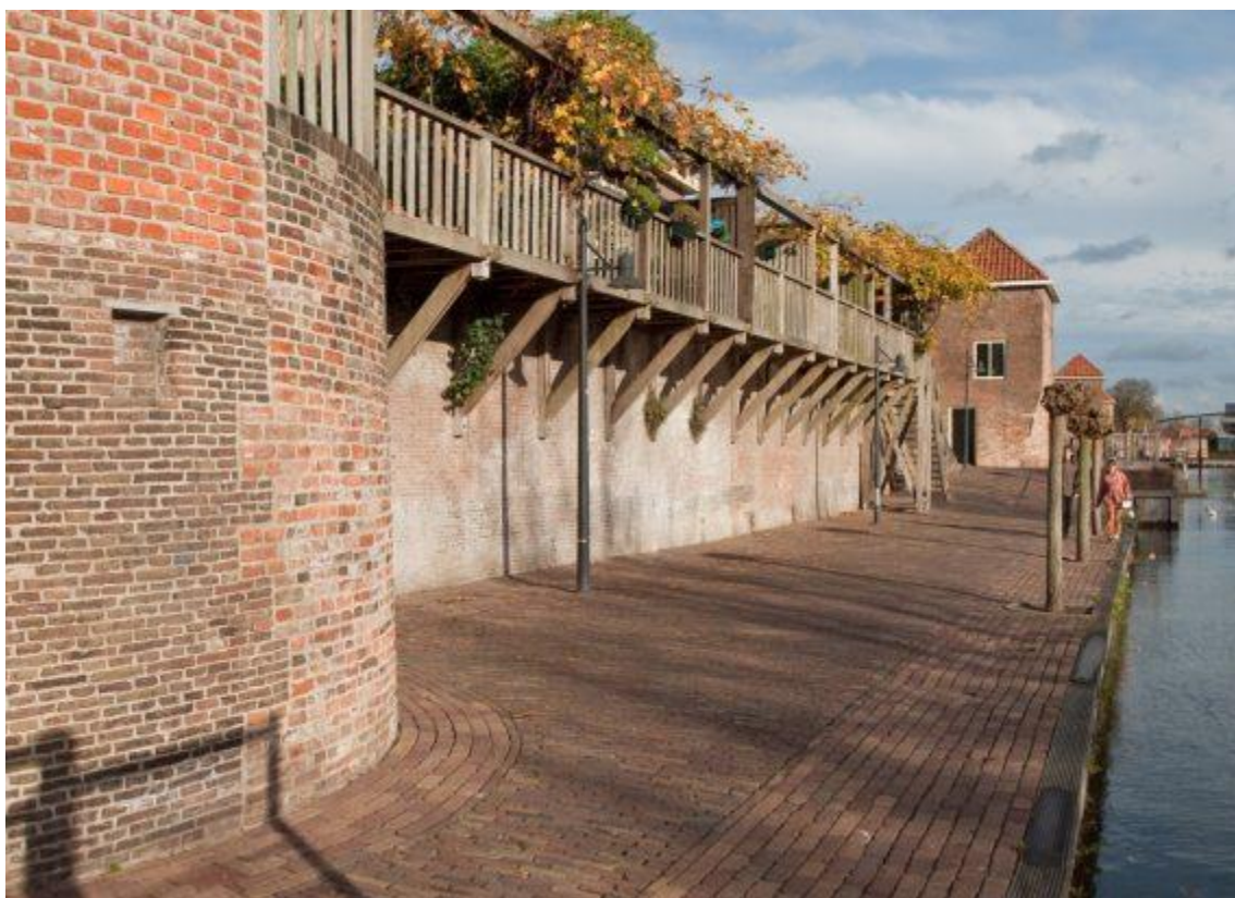
Figuur 76. De stadsmuur van Leerdam met torens is een voorbeeld van een middeleeuwse stadsmuur. Het water, nu een haven, is een oude zijtak van de Linge. Tussen de torens als hordijs aangelegde balkons van de tuinen van woningen aan de Hoogstraat. (Forten.nl).
