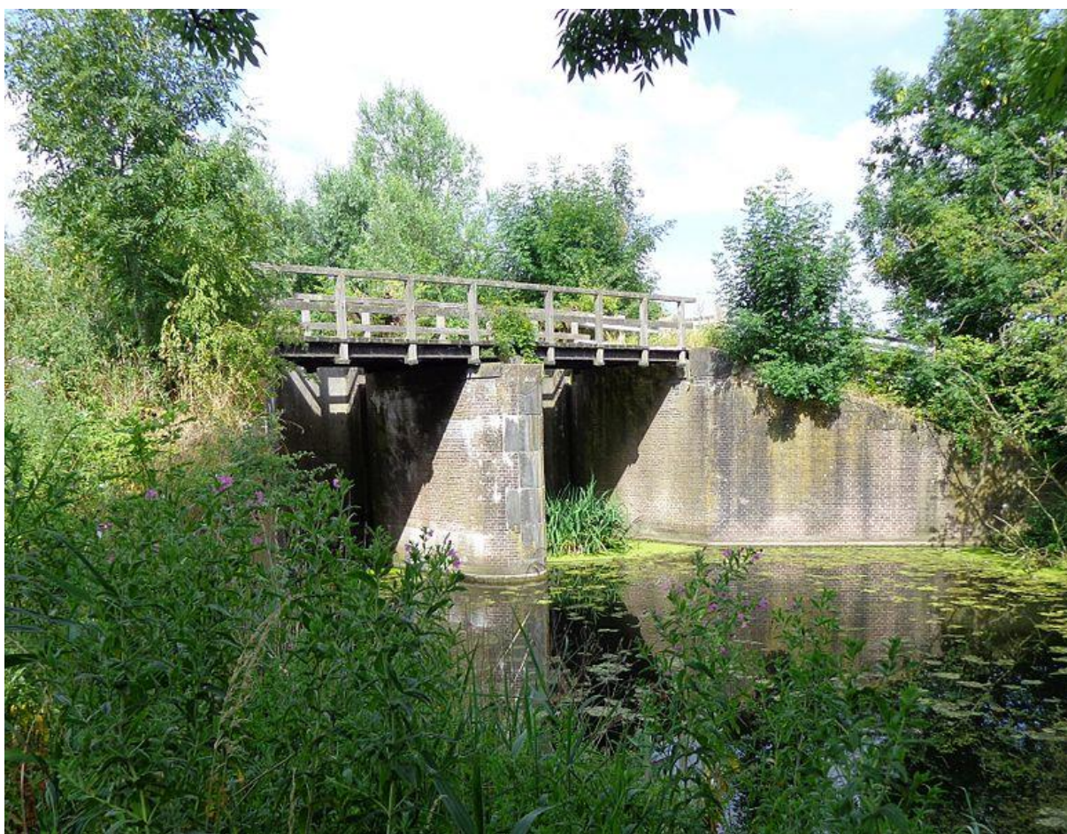
Figuur 80. De inlaatsluis ten noorden van Fort Everdingen aan de Lek. Rivierwater kon hier worden ingelaten om een deel van de Betuwe te inunderen en zo de waterlinie in werking te stellen. (Wikimedia Commons, gebruiker HenkvD).
