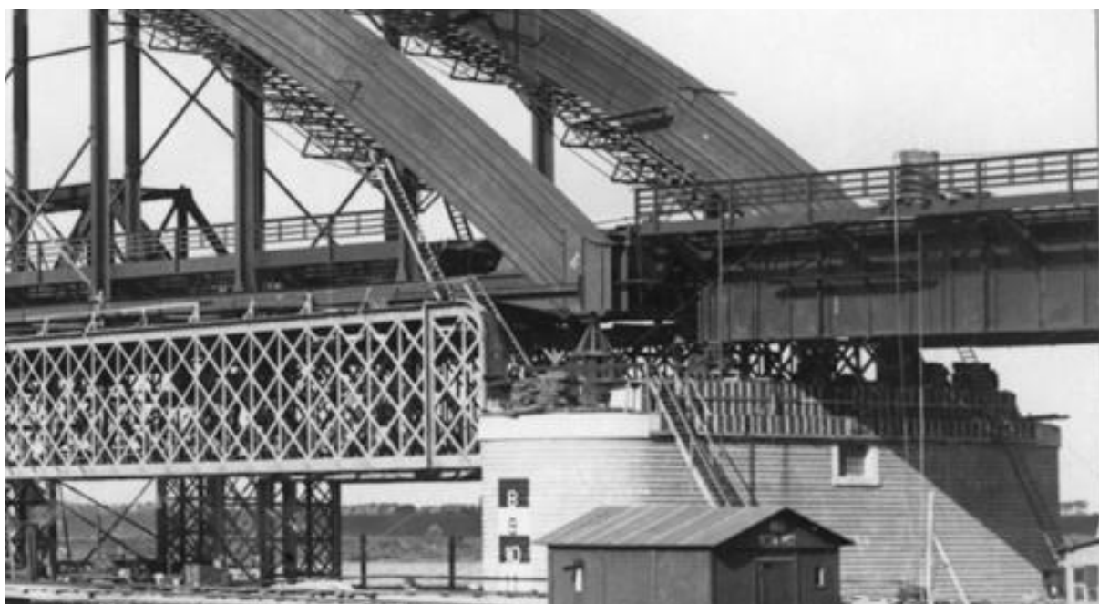
Figuur 73. De Lekbrug in aanbouw (1936). Het vierkante gat in de lange zijde van de pijler is een van de schietgaten van de burkazemat. Aan de waterzijde bevinden zich twee schietgaten. (St. Boogbrug Vianen, 2019).
