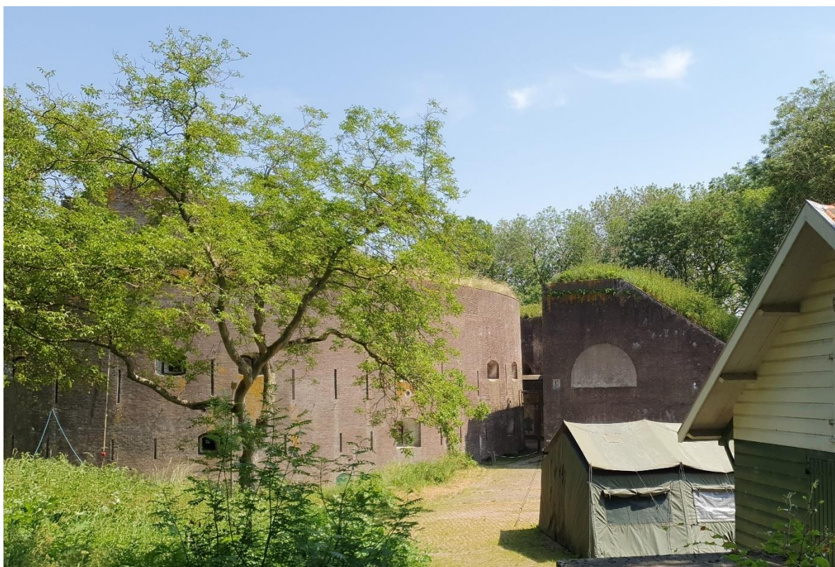
Figuur 66. Het centrale torenfort en de contrescarp van Fort Everdingen zijn beide bedekt met aarde ter bescherming tegen inslagen en daarom gekarteerd als aardwerken, evenals de bastions er omheen. (RAAP, 16-06-2021).
