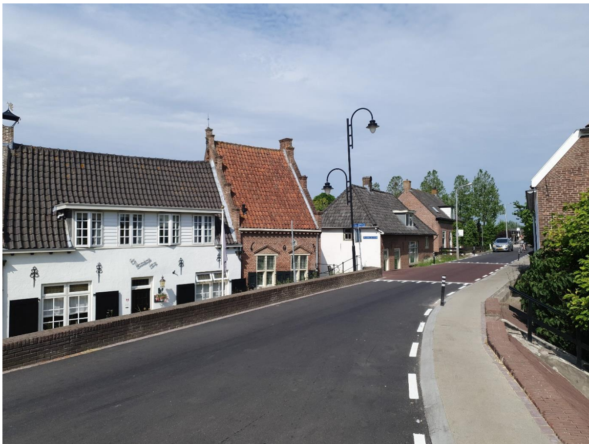
Figuur 57. De Lekdijk vormt een integraal onderdeel van de dorpsstructuur van Lexmond. Om het historisch karakter te behouden is de moderne hogere dijk om het dorp heen gelegd. (RAAP, 17-06-2021).
