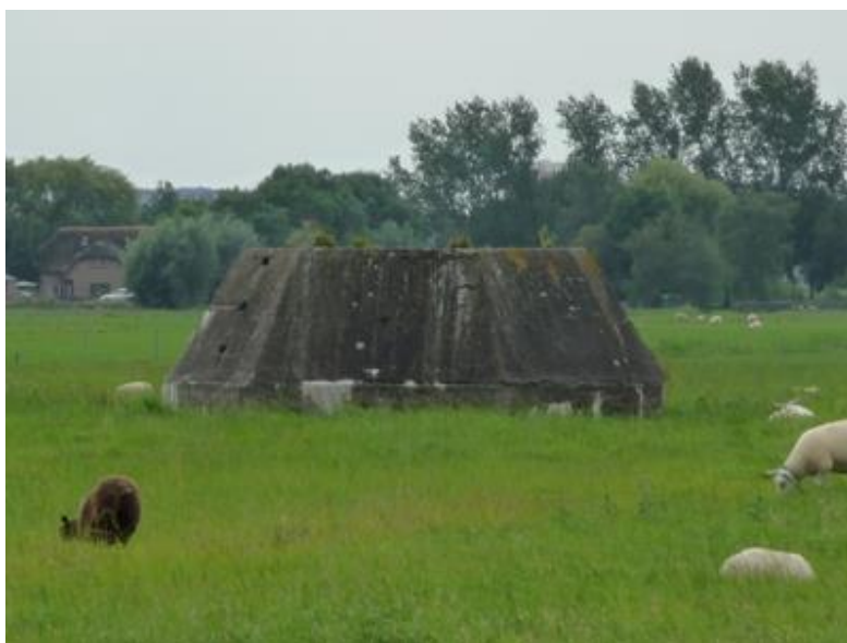
Figuur 78. Het restant van het radargebouw van station Gorilla. (Tracesofwar.nl).
