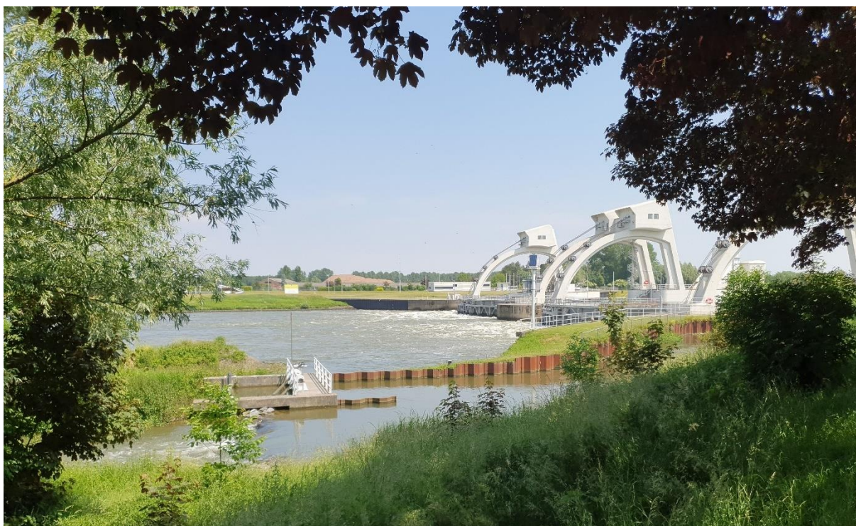
Figuur 64. De stuw bij Hagestein met op de voorgrond de vistrap. Aan de andere kant van het eiland in de Lek ligt de sluis. (RAAP, 16-06-2021).
