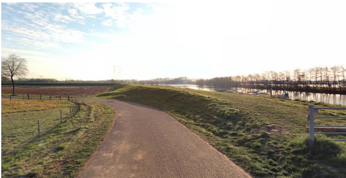
Figuur 1-1: Bestaande situatie langs de primaire kering, rechts het buitenwater met de primaire kering langs de weg Pol
